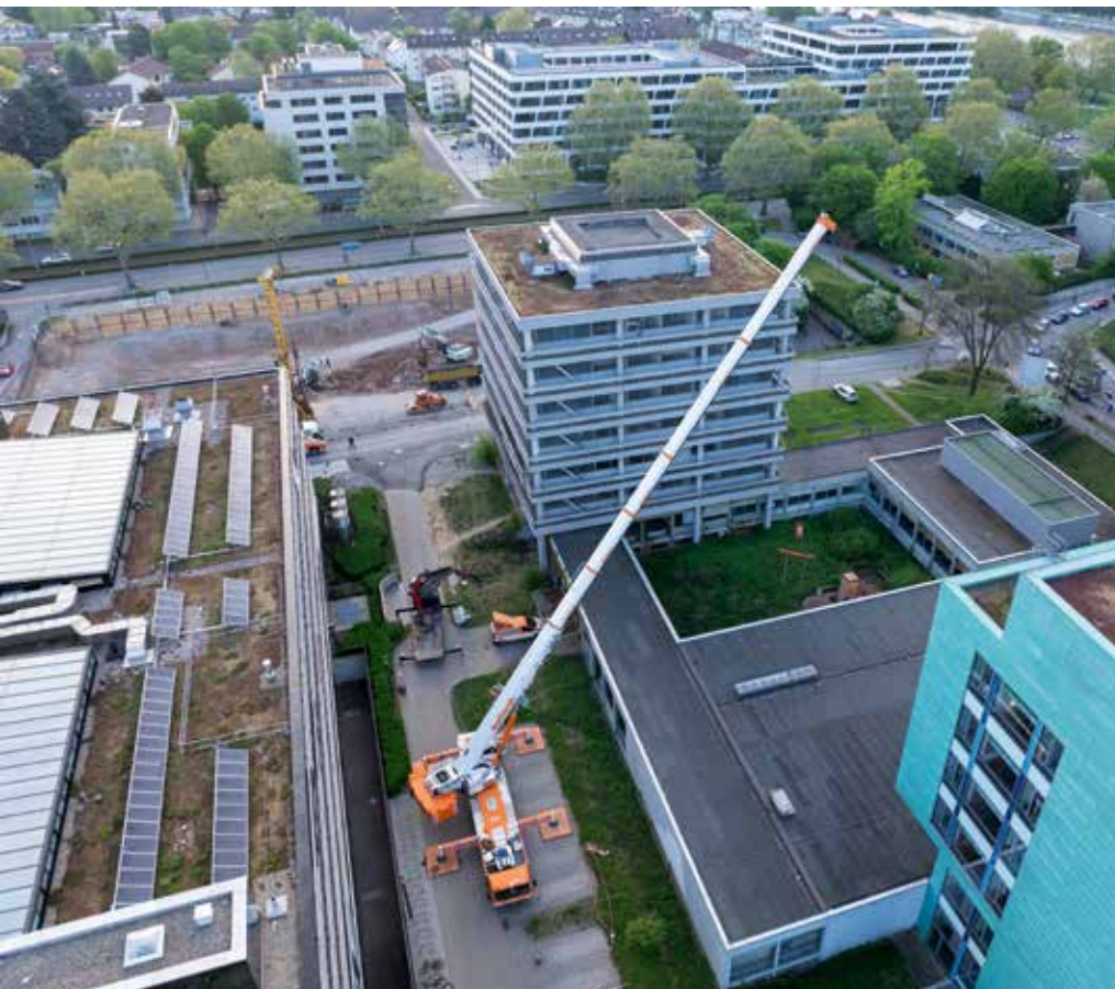
Die Skulptur ist vorbereitet, um an den AC 6.300-1 von Weiland angeschlagen zu werden.
