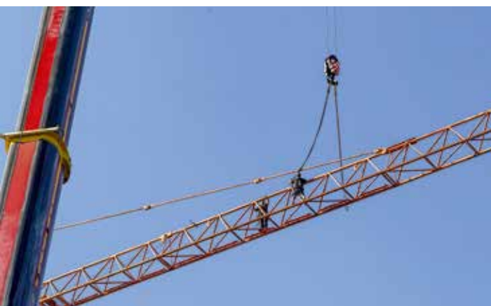
Nur etwas für Schwindelfreie: Die TDK-Auslegerteile werden in luftiger Höhe verbolzt.
