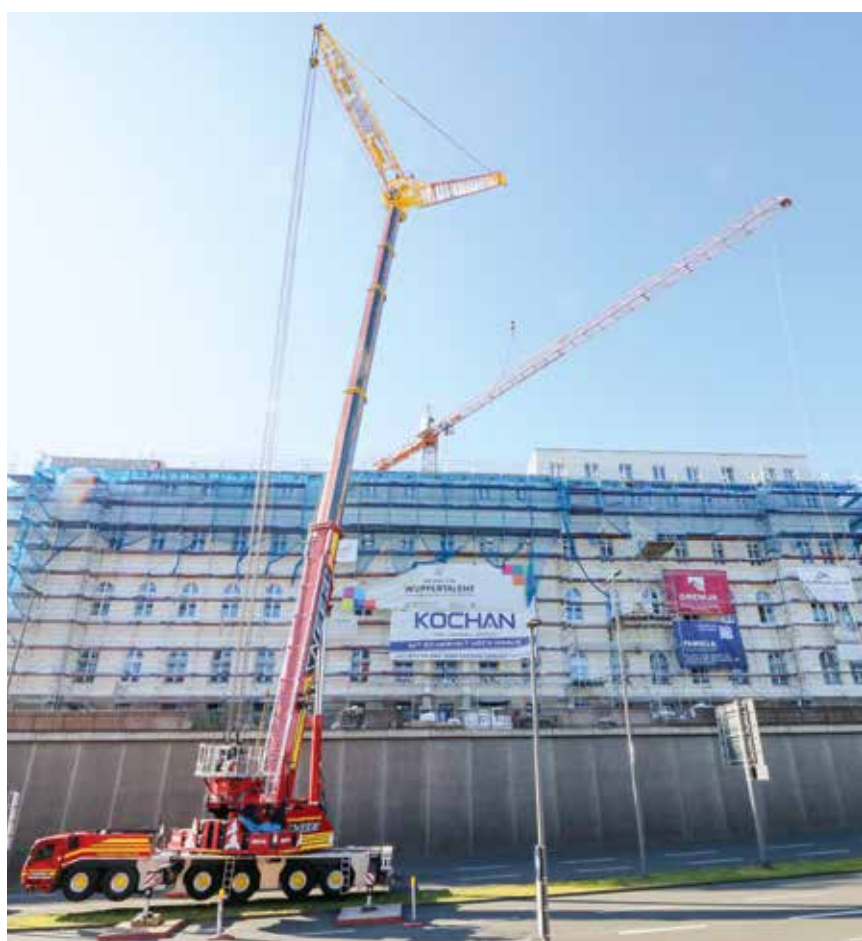
Die Montage ist ausgeführt.
