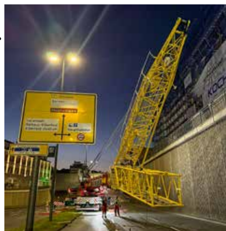
Schon während der Nachtstunden wird die Gittermastspitze des Grove GMK 6450-1 angeliefert und am Boden montiert.
