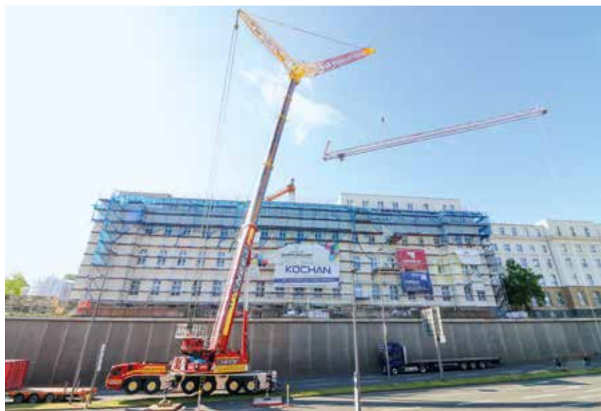
Auslegerteile des Turmdrehkrans werden eingehoben.
