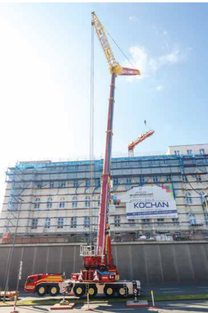
Neeb montiert einen Turmdrehkran hinter dem Gebäude der ehemaligen Bundesbahndirektion.
