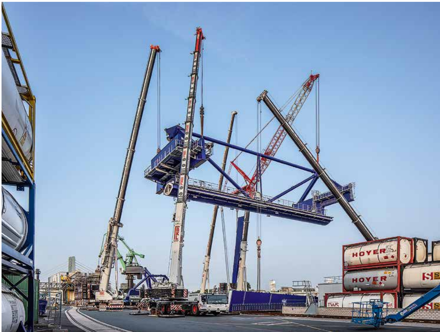
Drei Krane heben den 140 t schweren Hauptträger, ein Vierter eine Stütze.
