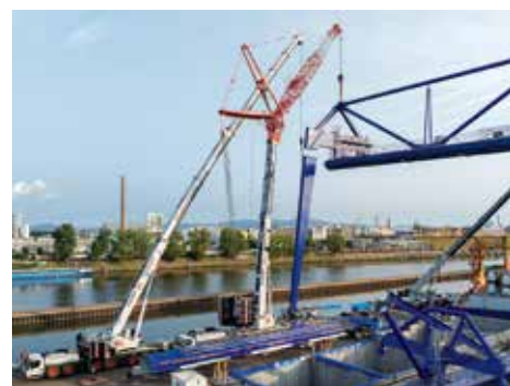
Kniffliger Hub des ersten Stützenträgers.
