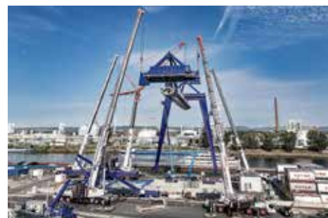
Kniffliger Hub des ersten Stützenträgers.
