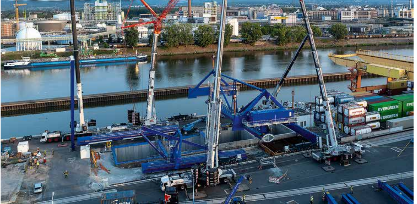
BKL im Einsatz mit fünf Autokranen in Frankfurt Höchst.
