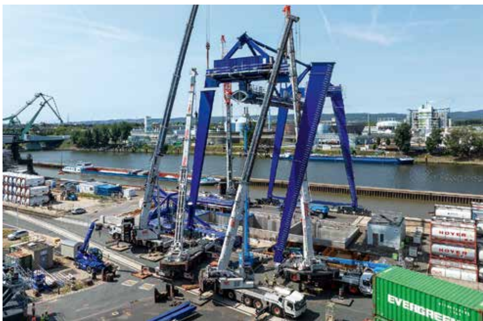
Fünf Mobilkrane bei der Montage des neuen Portalkrans in Frankfurt Höchst.
