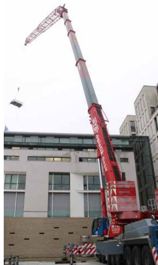
Neue Klimatechnikteile werden auf das Dach eines Geschäftshauses eingehoben.
