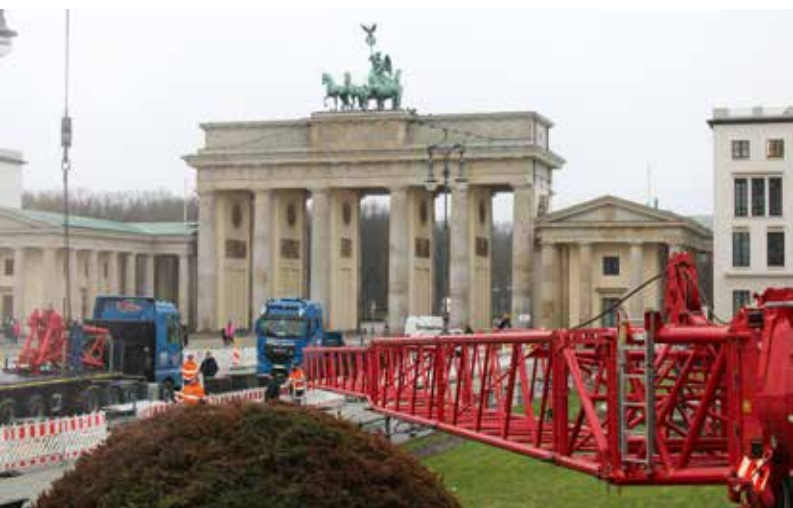
Die 35 m lange Gittermastspitze wird am Boden vormontiert.
