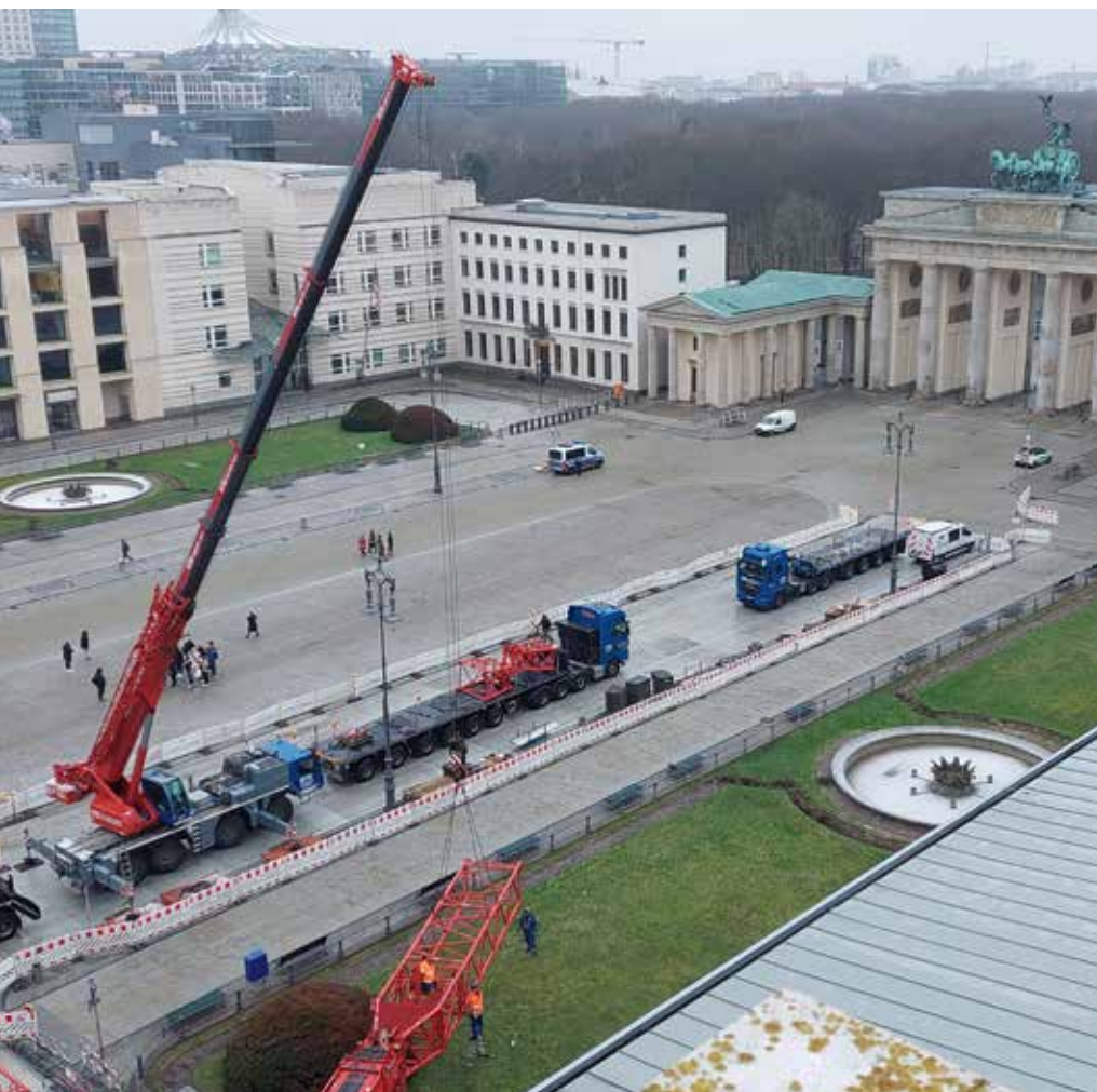
Der LTM 1090-4.1 hilft bei der Montage der Gittermastspitze für den Hauptkran.
