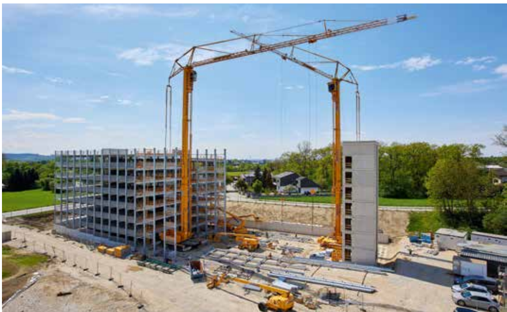
Der Spierings-Mobilbaukran hebt Stahlkonstruktionen für das Parkhaus.
