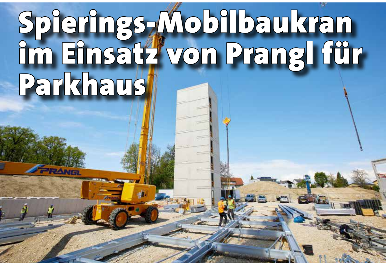
Prangl mit Bauarbeiten auf Parkhausbaustelle.
