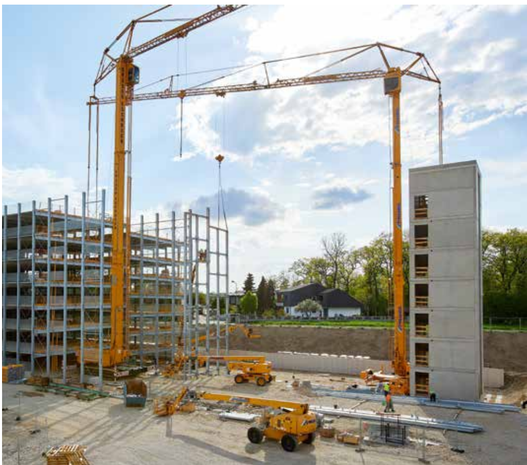
Der Mobilbaukran kann große Lasten heben und ist flexibel manövrierbar.
