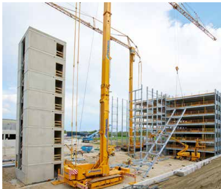
... und größerteilige Stahlelemente werden gehoben.
