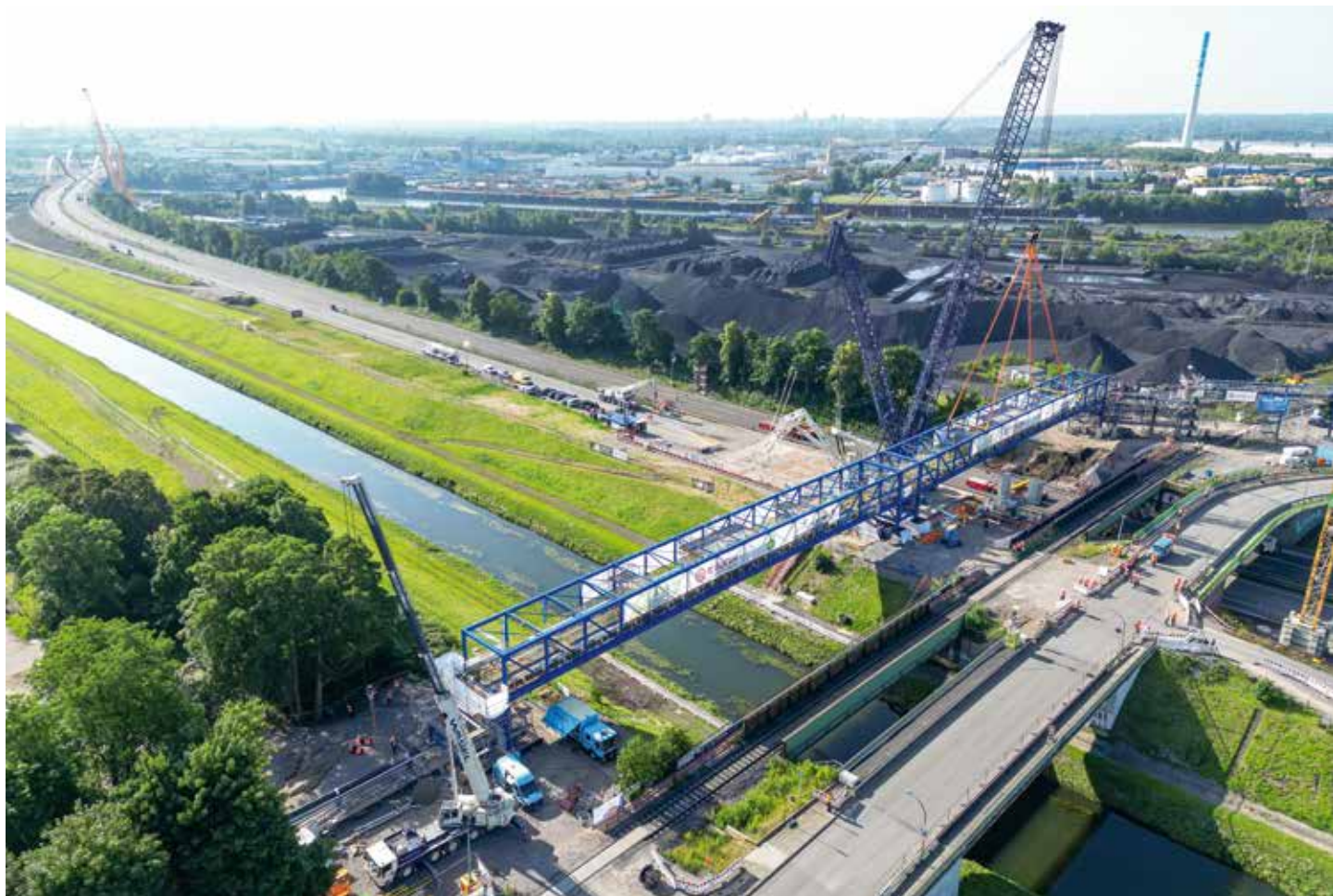
Das zweite Rohrbrückensegment wird über der A 42 eingehoben.
