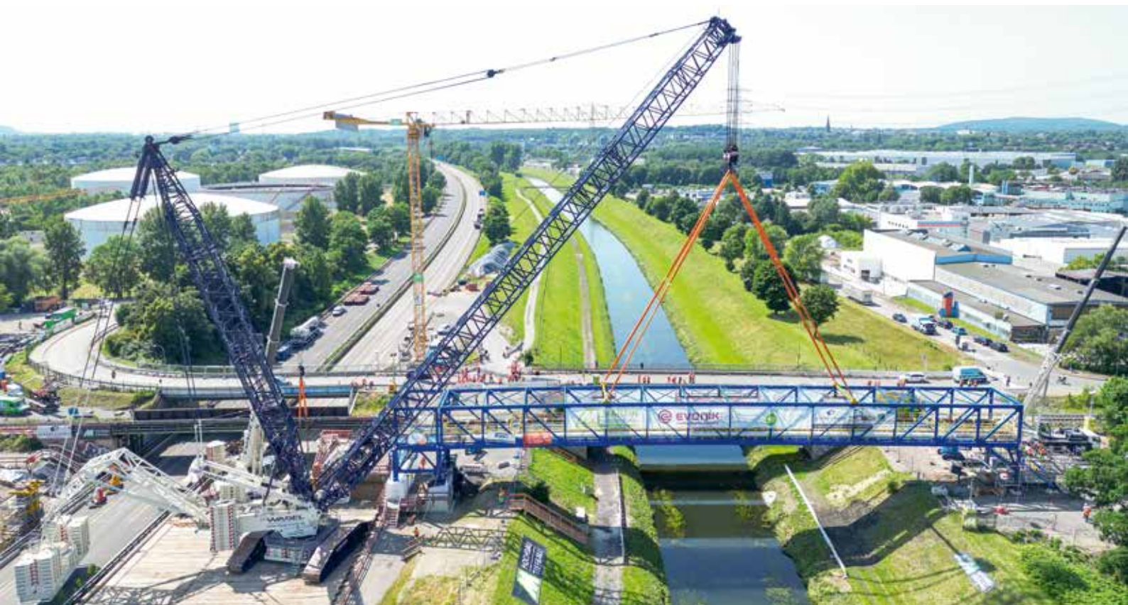
Die LR 11000 von Wasel platziert auf Harthölzern auf der gesperrten A 42.
