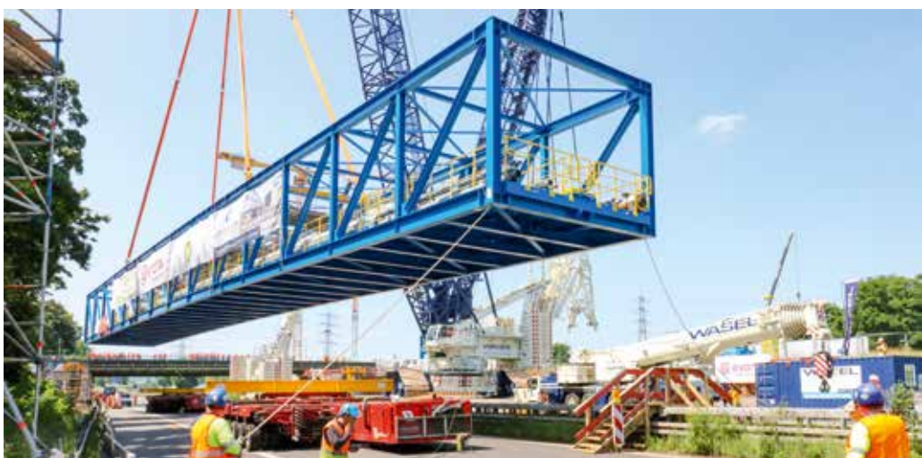
Das erste 220-Tonnen-Brückensegment wird von den SMPTs gehoben.
