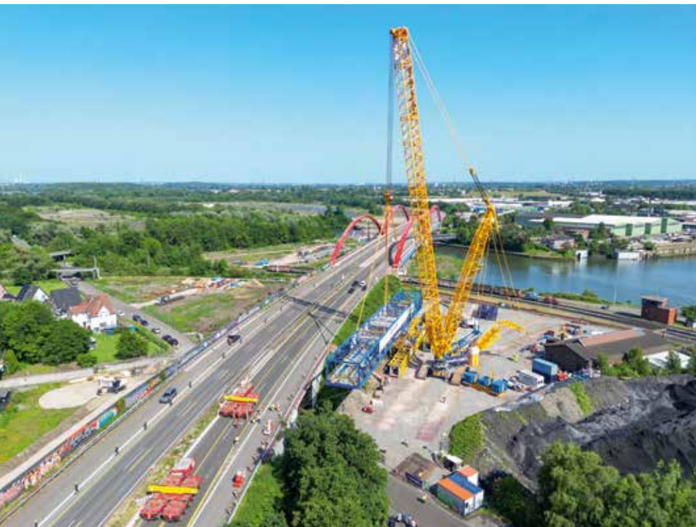
LR 11000 hebt das 220 t schwere Brückensegment auf SPMTs, die auf der A 42 bereitstehen.
