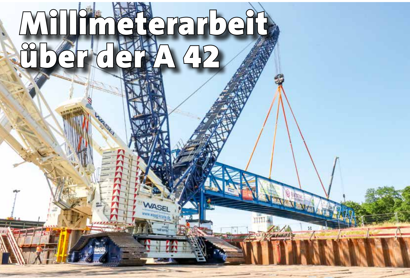
Einhub des ersten Rohrbrückenteils im Auftrag von Evonik.
