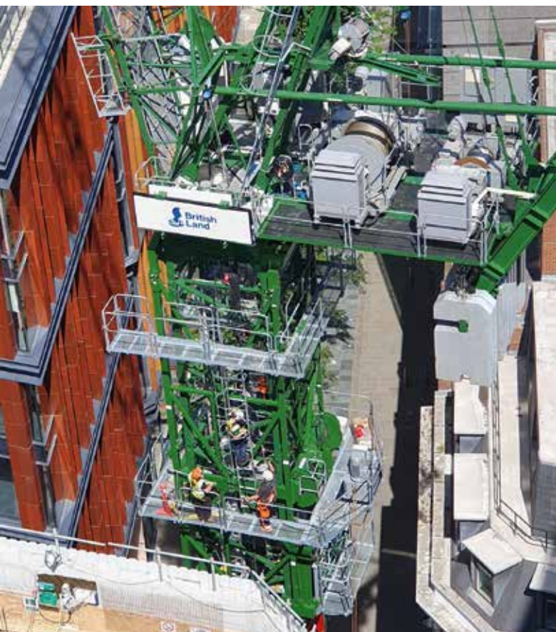
Der Potain MR 418 ist mit Cab-IN-Personenaufzug ausgestattet.
