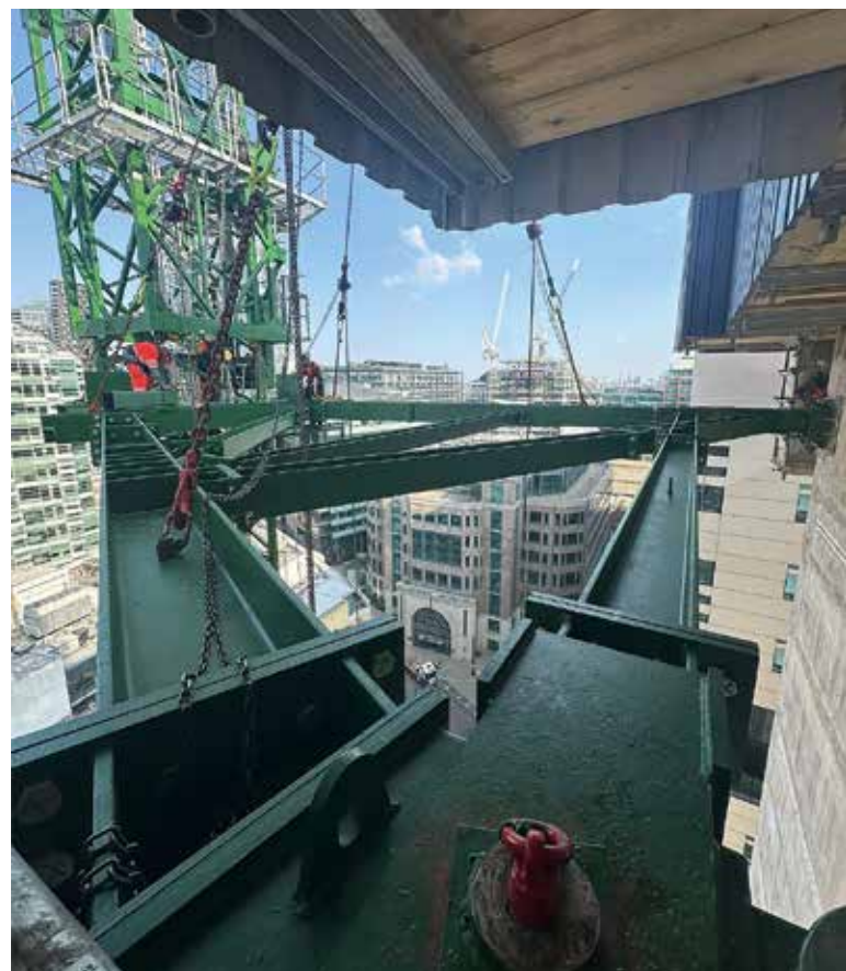
Kranbefestigung an der Hochhausfassade.
