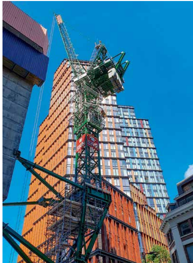
Potain-Krane bei der Errichtung eines 170 m hohen Hochhauses.
