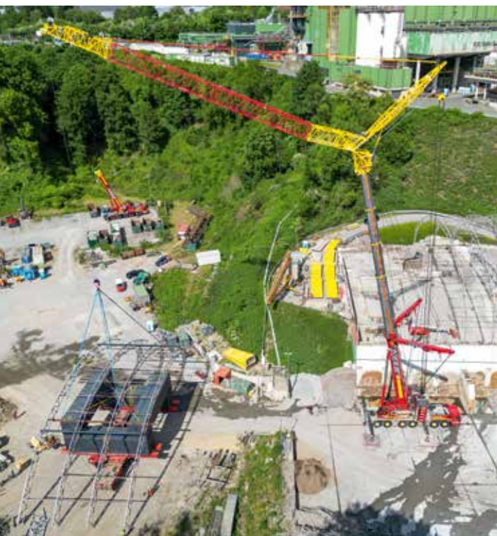
Der Grove GMK6450-1 gerüstet mit 135 t Gegengewicht, selbststrütender Mastabspannung und der 37 m Wippspitze.
