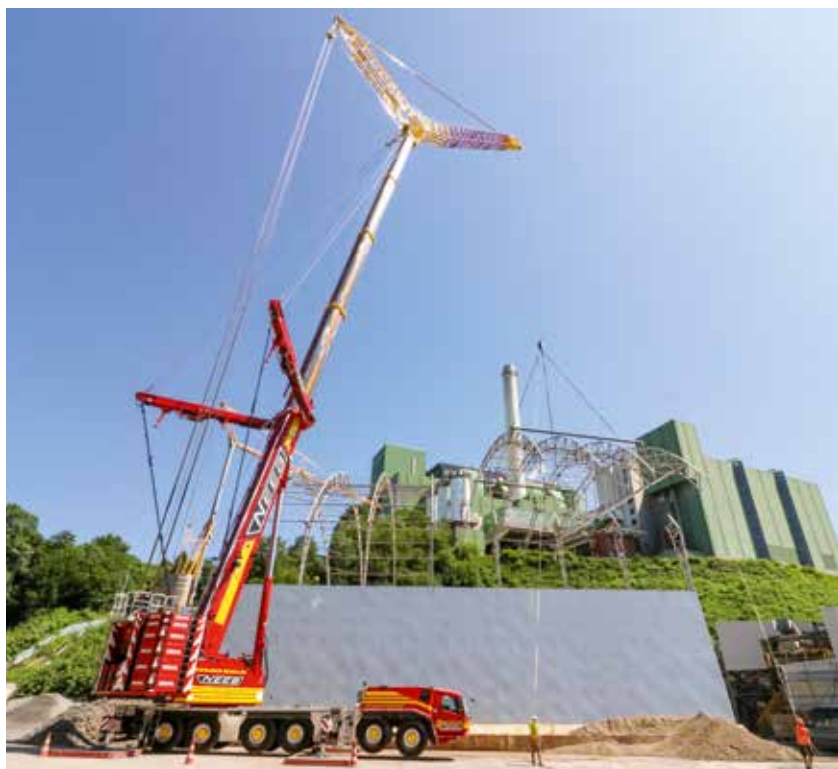
Die zweite Hälfte der Dachkonstruktion wird demontiert.
