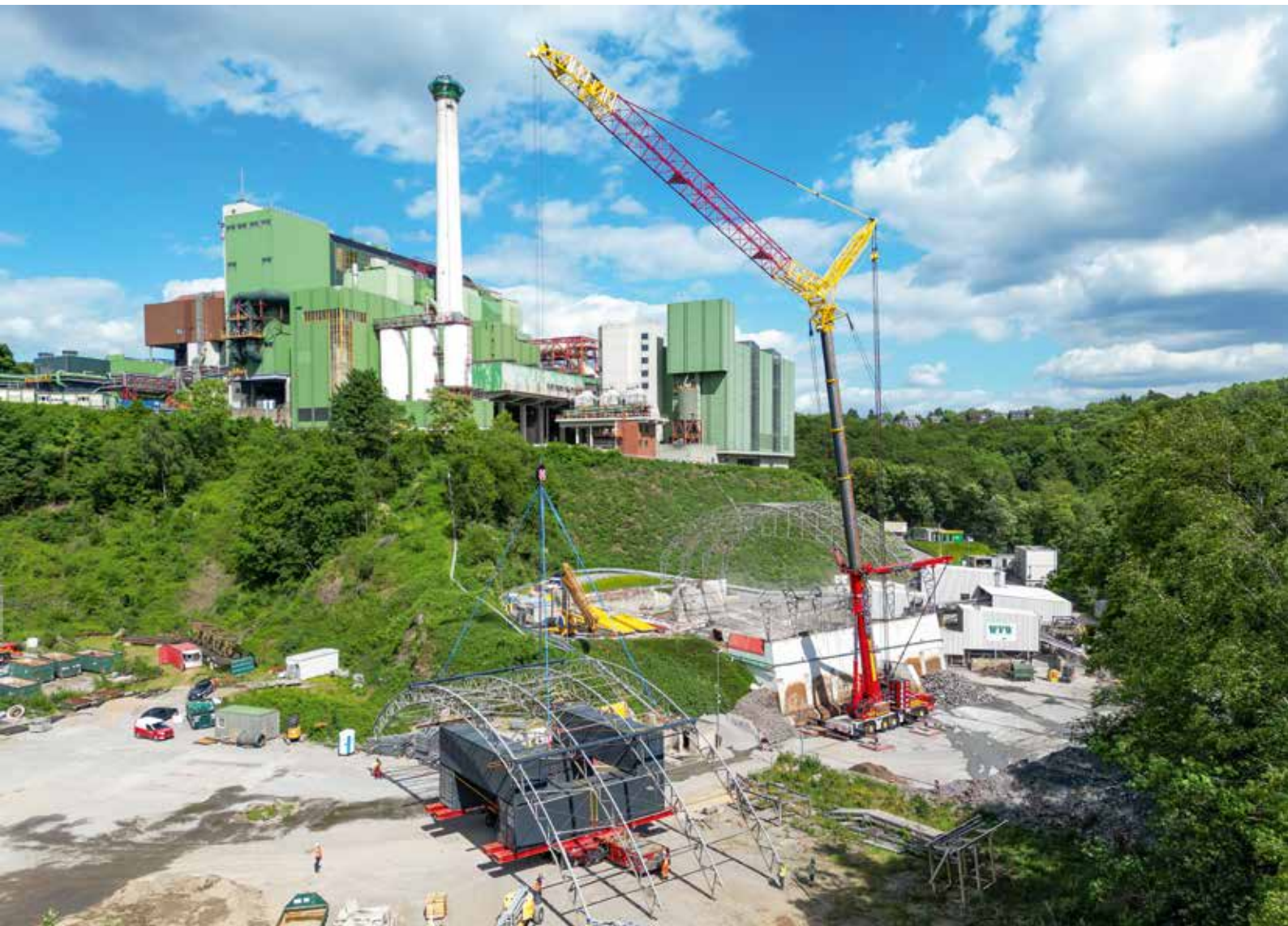
Der Grove GMK6450-1 von Neeb im Einsatz im MHKW Wuppertal.
