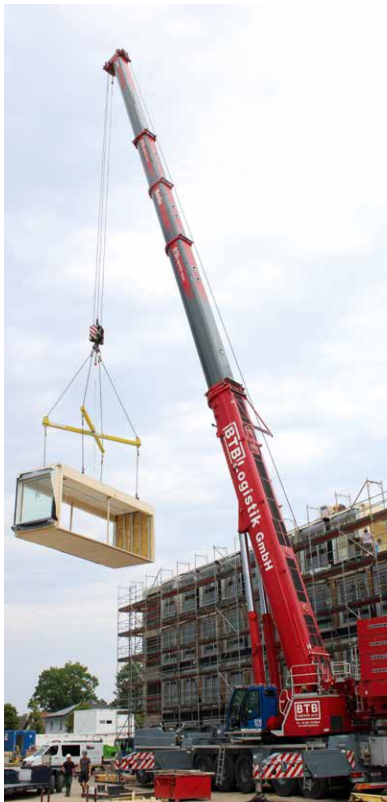
Einhub der Fertigbaumodule, angeschlagen an speziellen Traversen.
