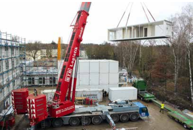
Lego für Große – schneller Baufortschritt mit vorgefertigten Modulen.
