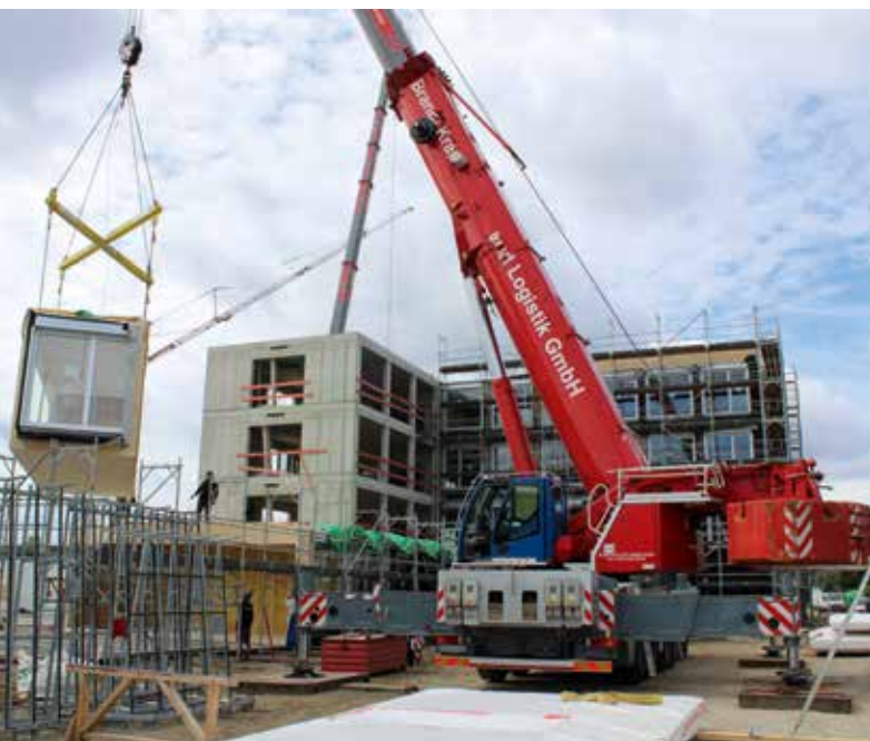
Der LTM 1230-5.1 im Einsatz für die Berliner Schulbauoffensive.
