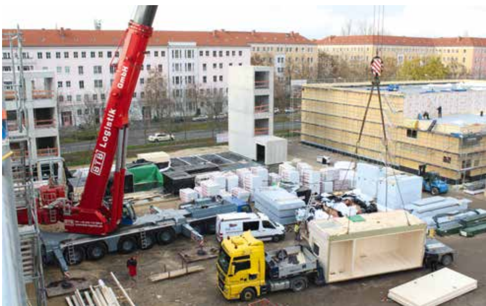
Die Module werden mit hohem Ausstattungsgrad auf den Baustellen angeliefert.
