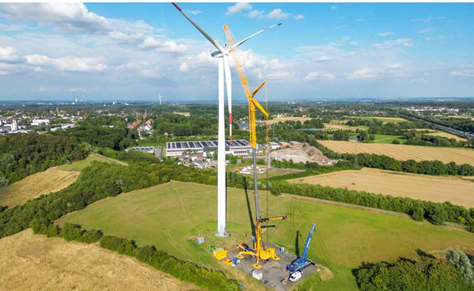
Der 50 Tonnen schwere Rotor wird wieder eingehoben.
