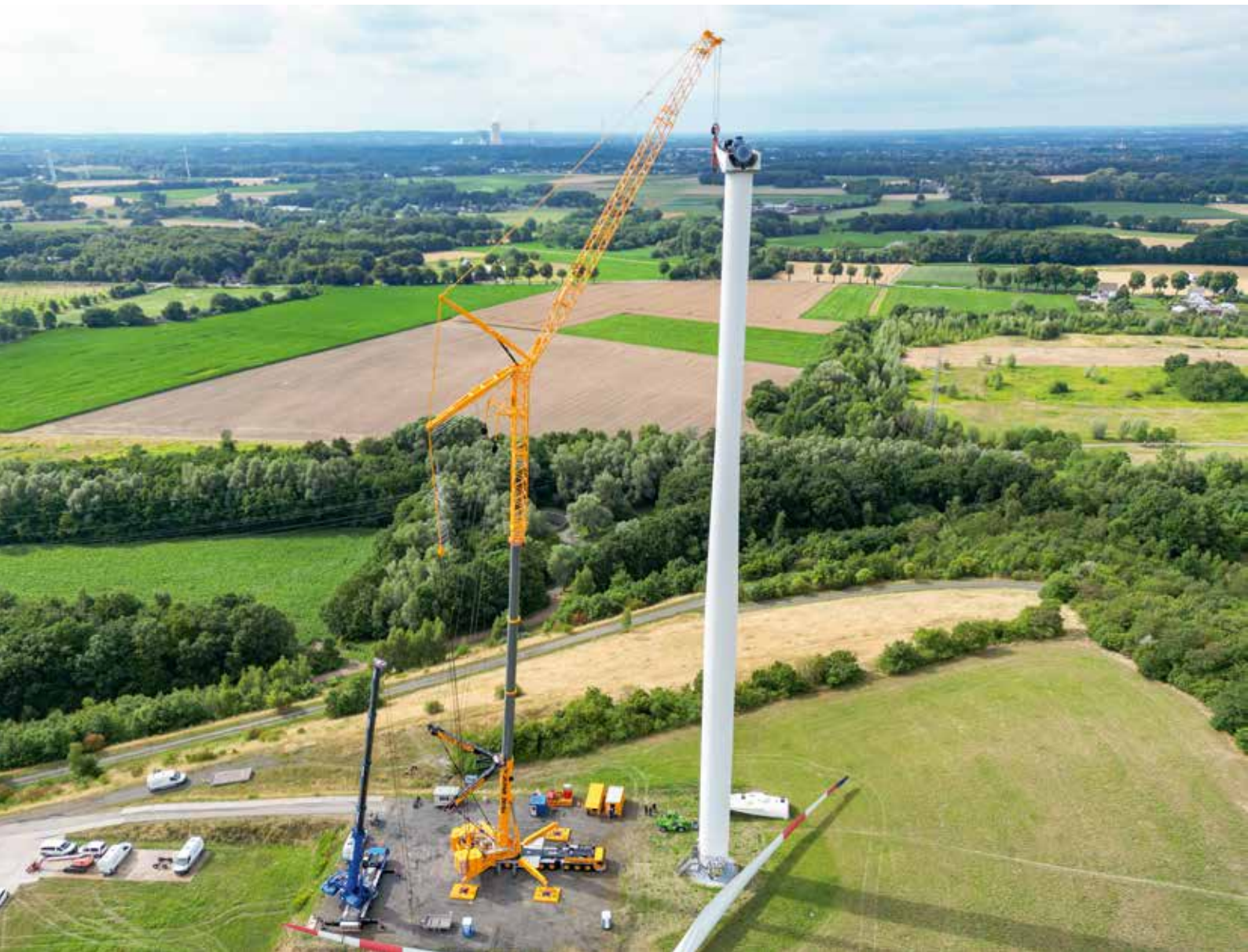
Nun kann die Hauptwelle in 100 Metern Höhe ausgewechselt werden.
