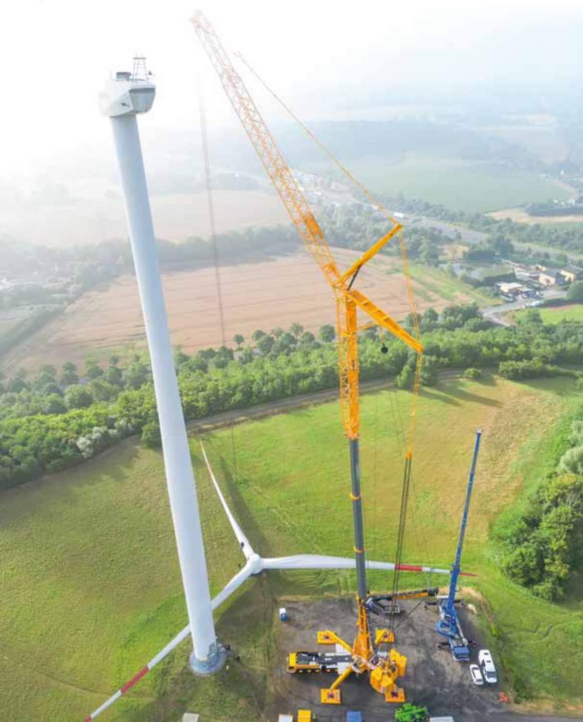
Der demontierte Rotor ist am Boden abgelegt.
