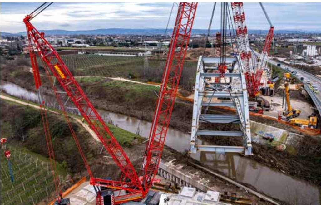
Der Tadano CC 38.650-1 hebt mit von der anderen Flussseite.
