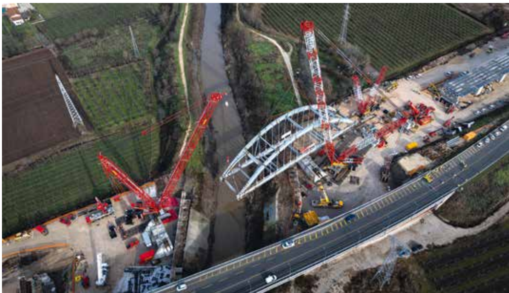
Drei Gittermastraupen beim Hub einer Eisenbahnbrücke bei Soave.
