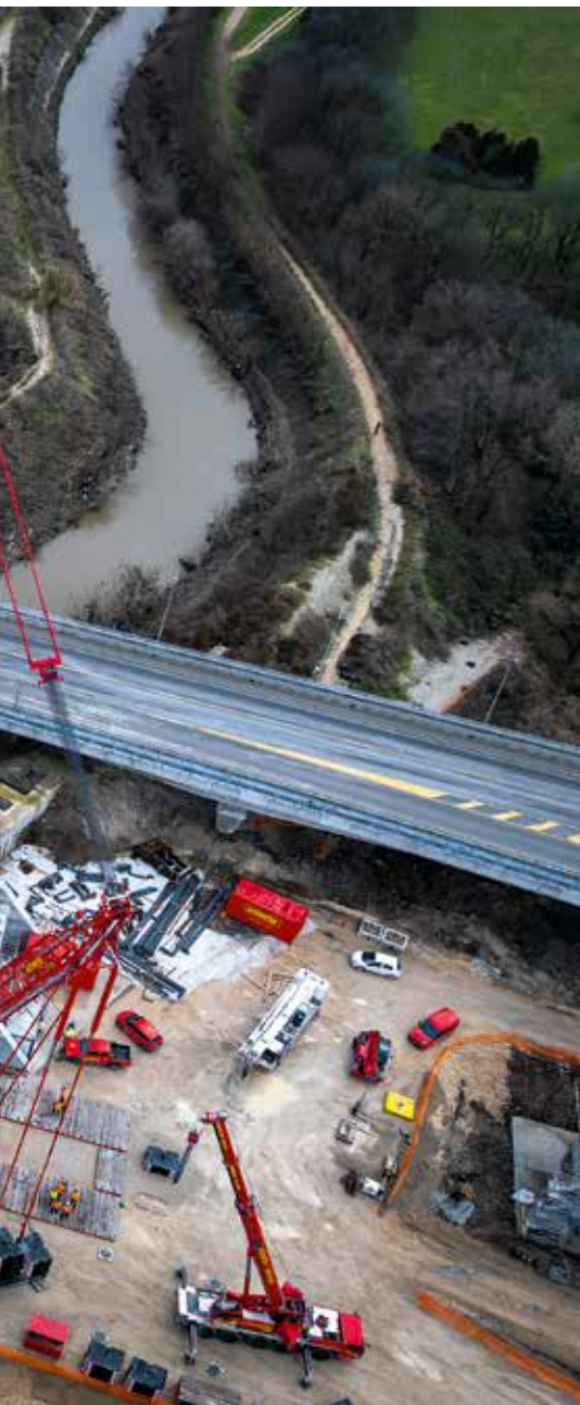
Drei Gittermastraupen beim Hub einer Eisenbahnbrücke bei Soave.
