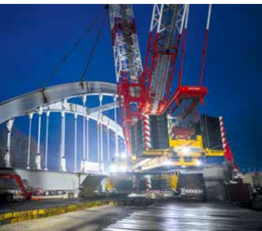
Der CC 38.650-1 verfährt mit 728 t Last 45 m über eine doppelte Bongossi-Schicht.
