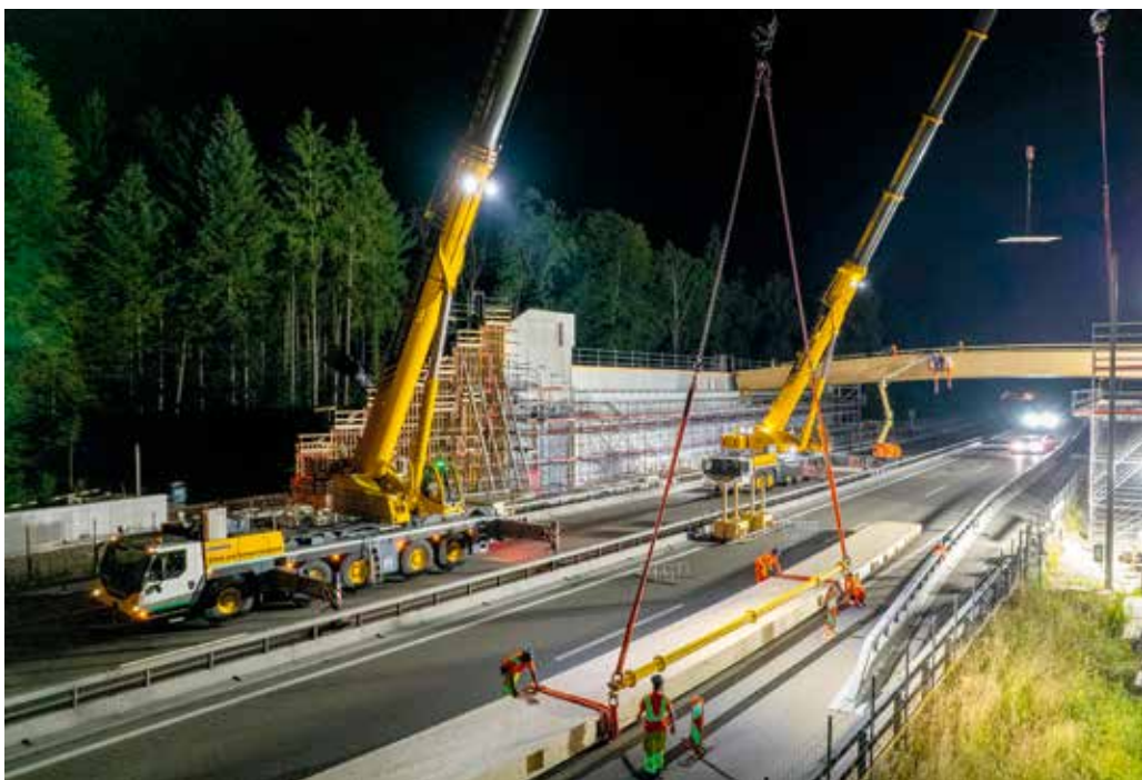
Ein LTM 1160-5.2 war auf der gesperrten A1 platziert, um die Holzbinder zu entladen und in den Halterahmen des 300-Tonnners zu setzen.
