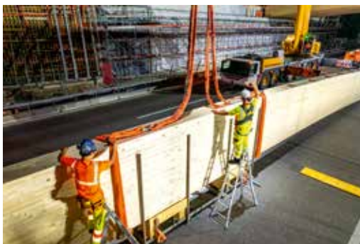
Kranfahrer Mathias Alram holt mit dem LTM 1300-6.2 die drei Meter hohen Bauteile ab und liefert sie zur Montage.
