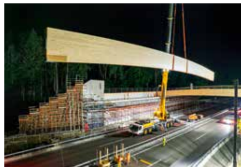
Kranfahrer Mathias Alram holt mit dem LTM 1300-6.2 die drei Meter hohen Bauteile ab und liefert sie zur Montage.
