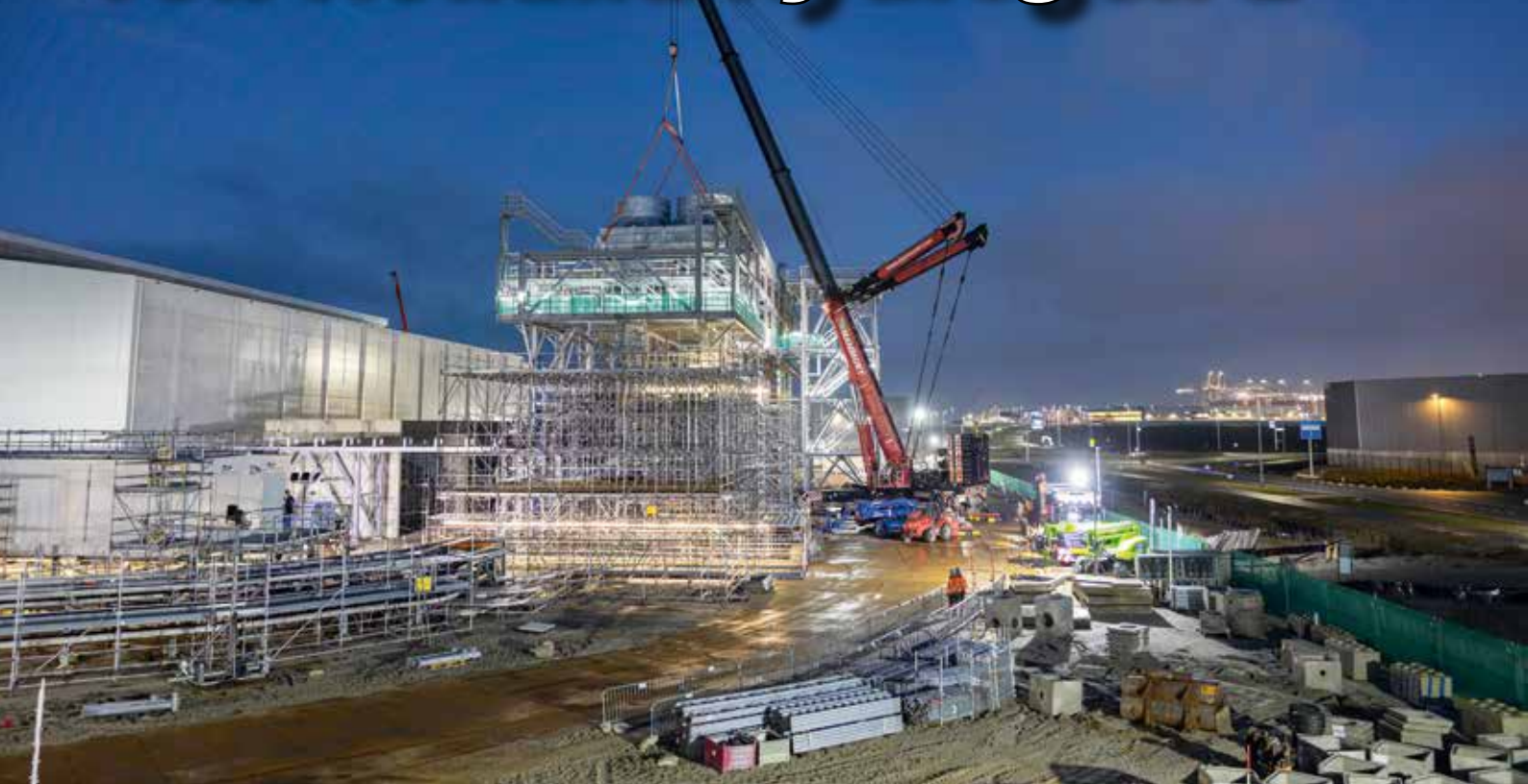
Die Baustelle von Shells Holland Hydrogen 1.
