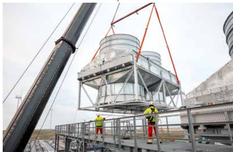
Einhub der Elektrolyseur-Komponenten.
