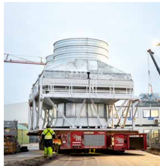
An Land werden die Elektrolyseur-Komponenten mit SPMTs transportiert.
