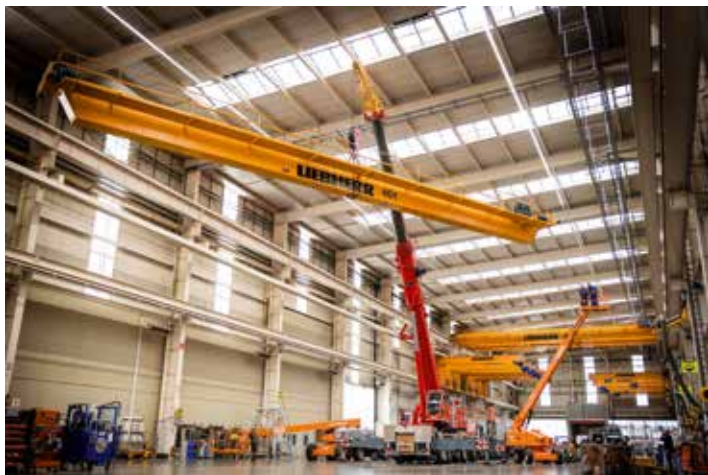
Ein LTM 1110-5.1 von Rieger & Moser demontiert die alten Brückenkranen und hebt die neuen Hallenkranen ein.
