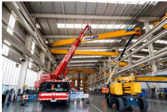
Ein LTM 1110-5.1 von Rieger & Moser demontiert die alten Brückenkranen und hebt die neuen Hallenkranen ein.
