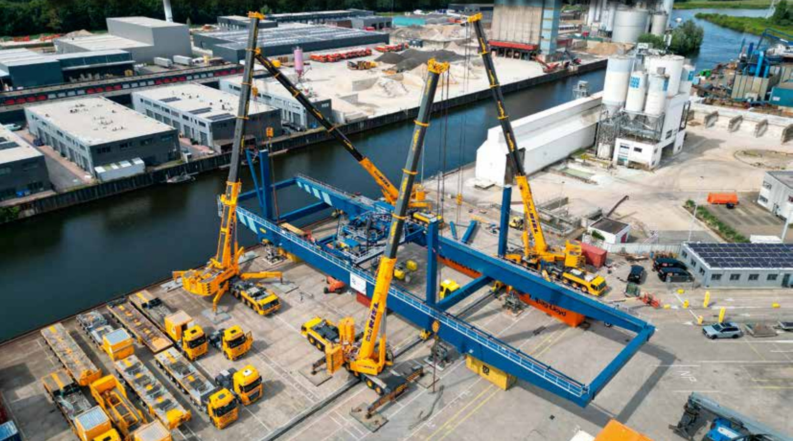
Quattro-Hub eines Portalkrans im Hafen von Den Bosch (Niederlande).
