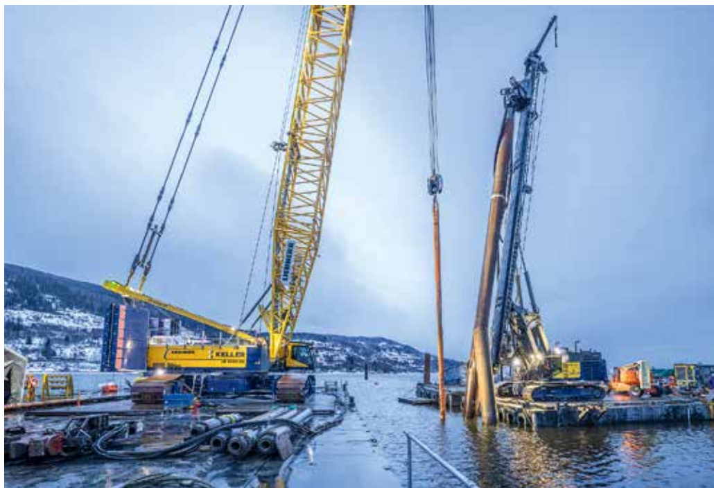
Die Neigung der schwimmenden Konstruktion wird in der eigenen Betriebsart während des ganzen Einsatzes überwacht.
