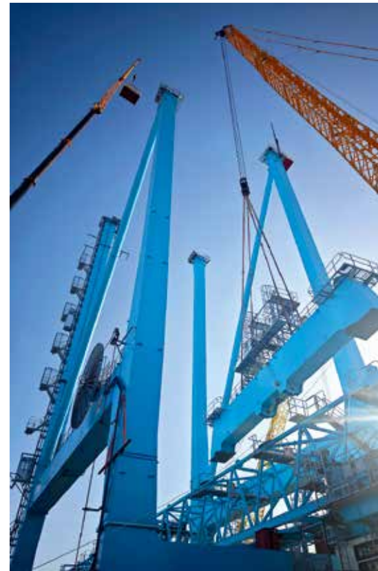
Die eingesetzten Raupenkrane konnten 600 Tonnen stemmen.
