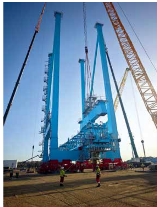
Vier Krane waren im Einsatz, um einen STS-Kran zu montieren.
