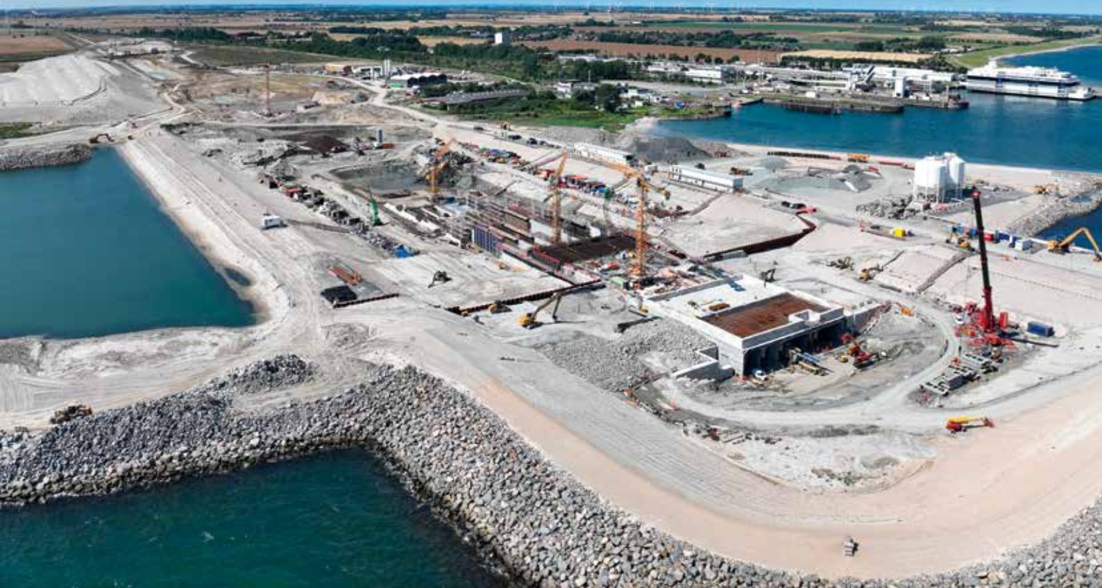
Schienengebundene Liebherr Turmdrehkrane beim Bau des Fehmarnbelt-Tunnels.
