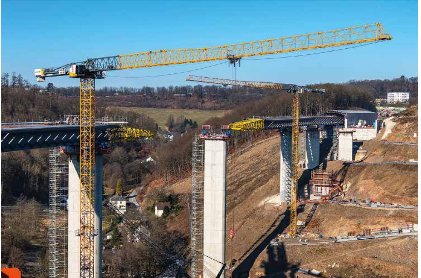
Baubeginn der Arbeiten an der A 45-Brücke im Herbst 2023.
