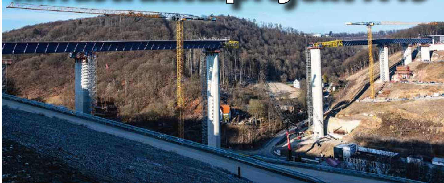
Liebherr TDKs 340 EC-B 16 von BKL im Einsatz an der Rahmedetalbrücke.
