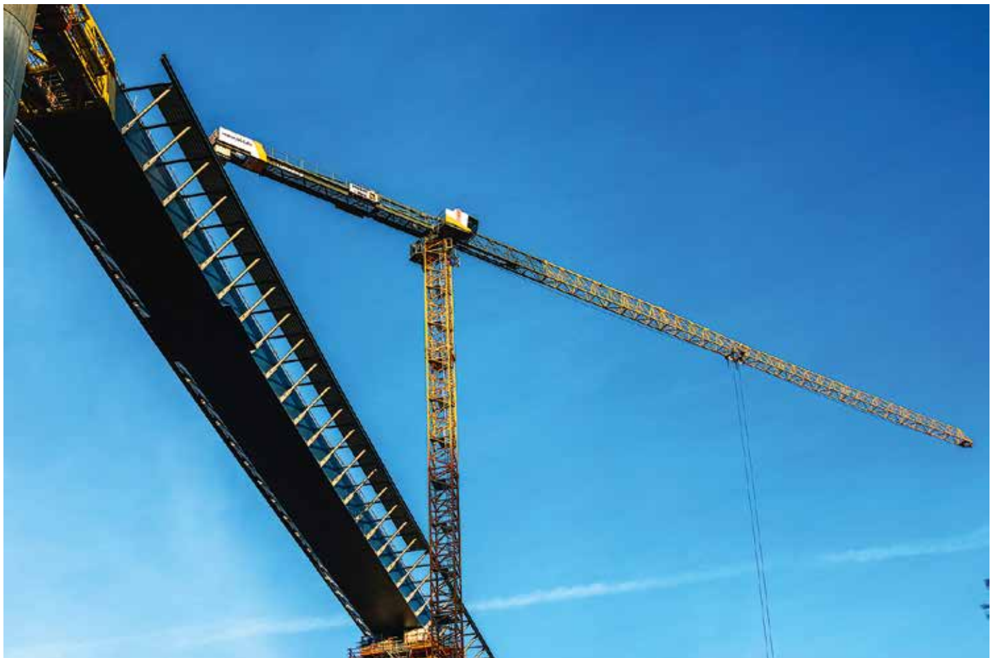
Die Rahmedetalbrücke überspannt eine Länge von 453 Metern.
