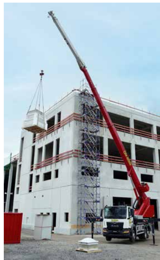
Der Böcker AK 48e beim Einhub von 400 kg schweren Paletten.
