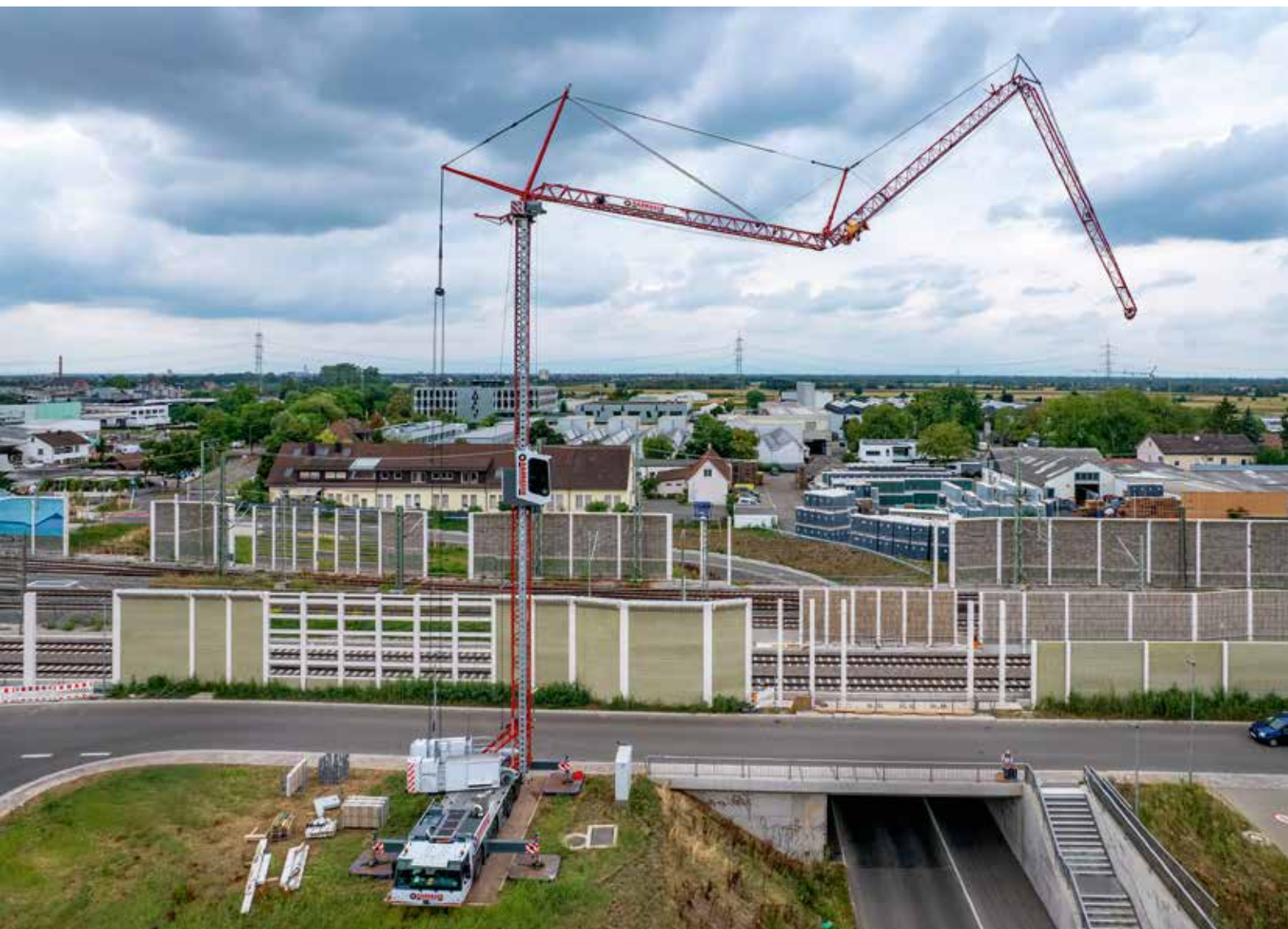
... noch beim zügigen, vollautomatisierten Zusammenklappen des Krans.
