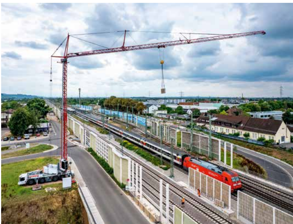
Vom Gleisbett aus steuert Kranfahrer Steffen Held die Elemente für die Schallschutzwand.
