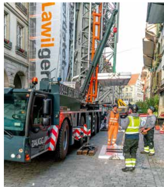
Ein kleiner Hilfskran ermöglichte ein zügiges Auslegen der Lastverteilerplatten.
