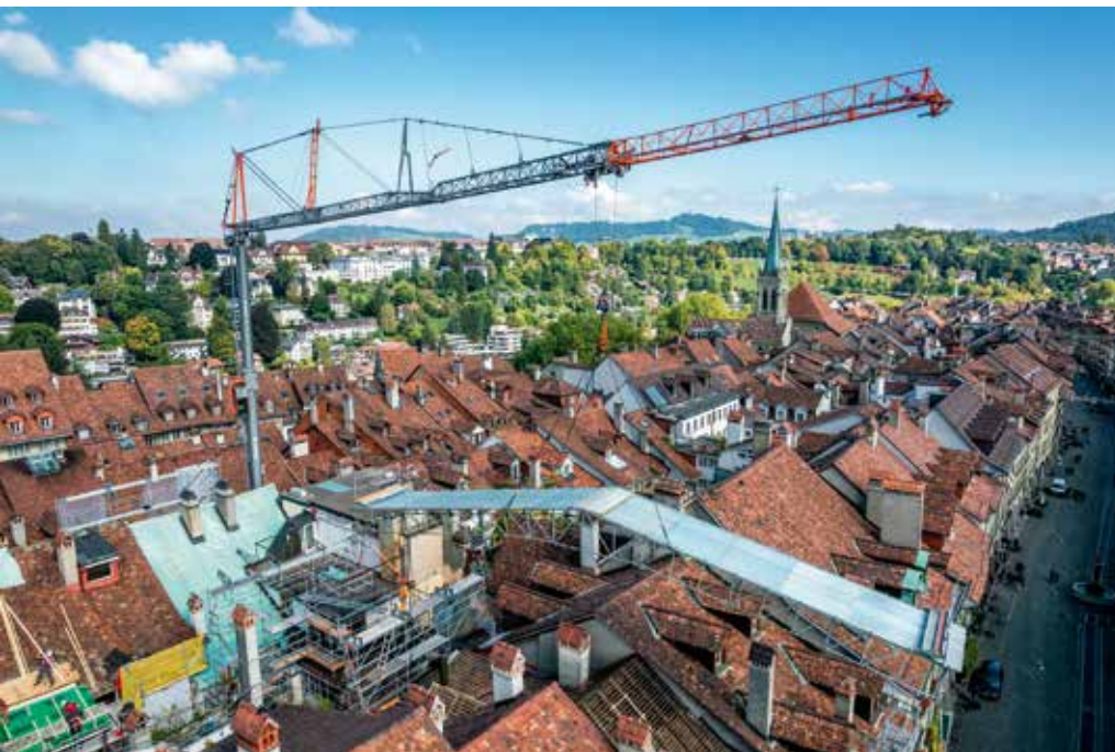
In Entfernungen von bis zu 45 Metern musste der Mobilbaukran große Dachkonstruktionen platzieren.
