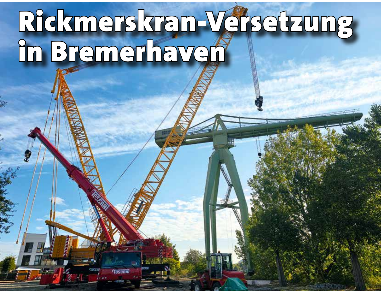
Die Montage des LR 1600/2 und Mannkorbeinsätze erledigte ein LTM 1250-6.1.
