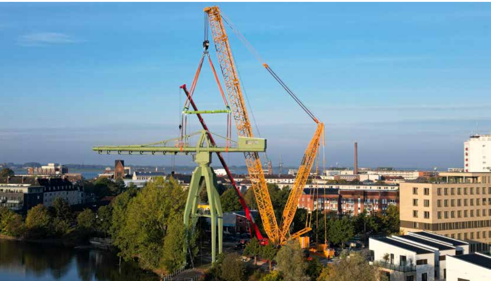
Der eingeschränkte Bauplatz erforderte besondere Aufmerksamkeit.
