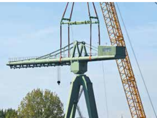
Nach der Mittagspause trennten sich beide Baugruppen voneinander.
