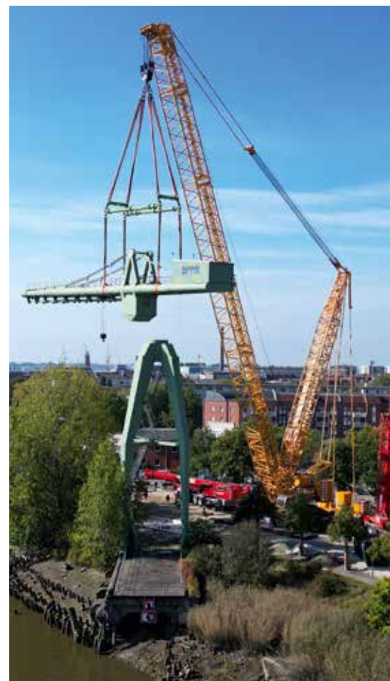
Während des Schwenks zur Zwischenlagerstelle musste darauf geachtet werden, dass Gitterausleger und Ladung sich nicht berührten.
