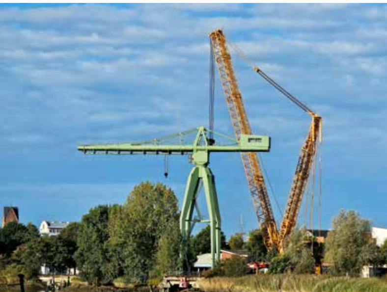
Das instabile Fundament reichte direkt bis an die Geeste.
