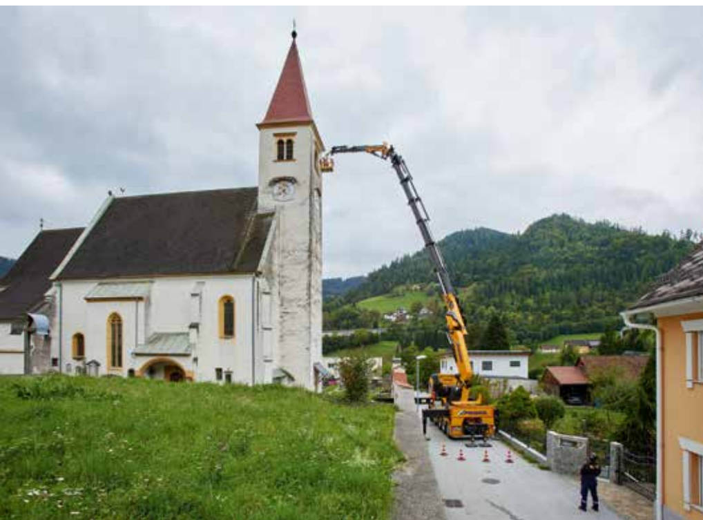
Der Mannkorb am Ladekran hob Monteure und Material.
