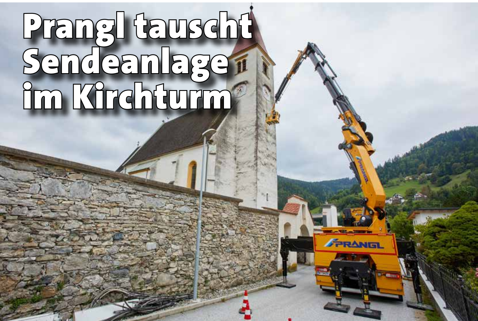
Prangl-Einsatz mit Ladekran an Kirchturm in Übelbach, Steiermark.
