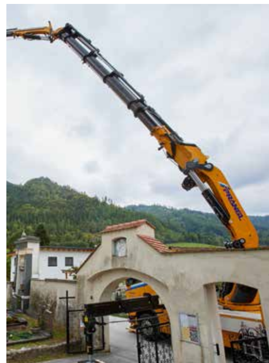
Die Hauptstütze des Krans musste durch das Tor in den Friedhof verlegt werden.
