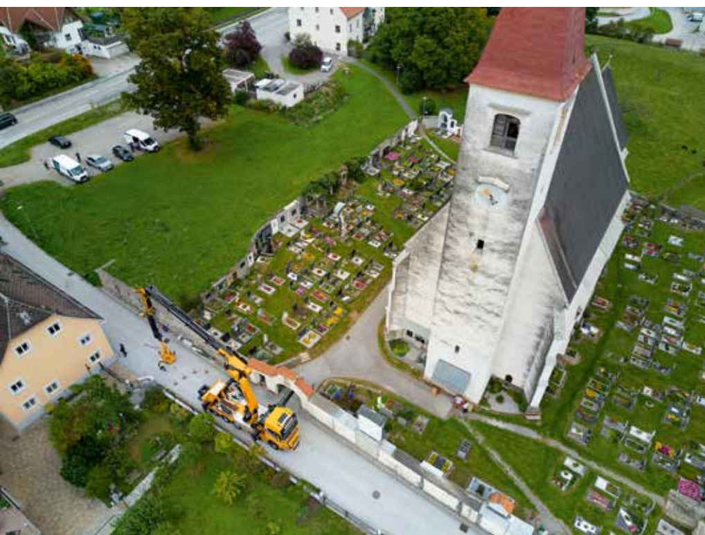
Die Platzverhältnisse erforderten originelle Lösungen.
