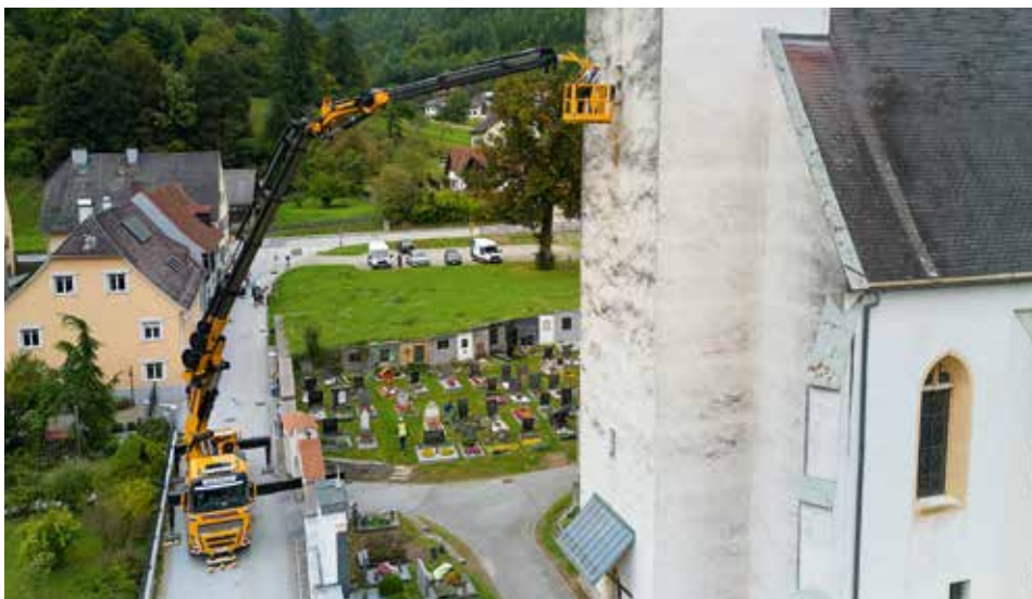
Durch die Fenster im Turm konnte Material angereicht werden.
