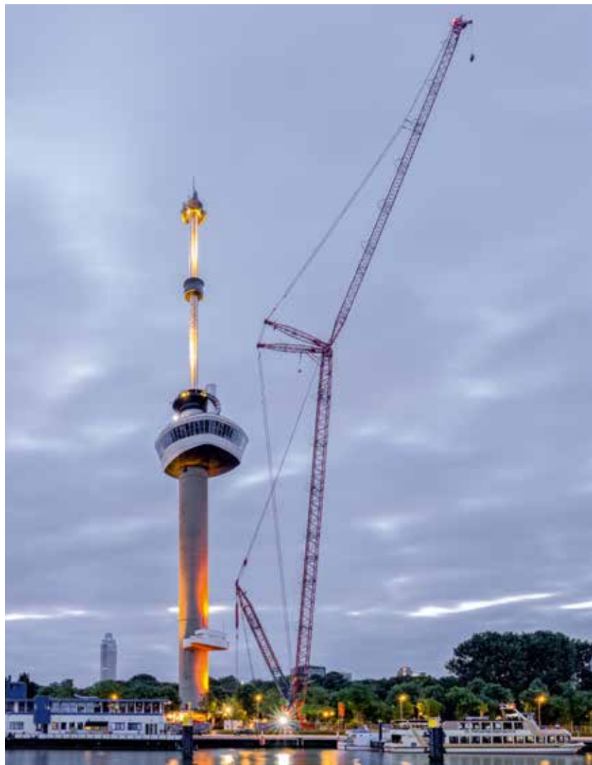
Ein CC 38.650 von Mammoet beim Einsatz im Rotterdamer Floriadepark.
