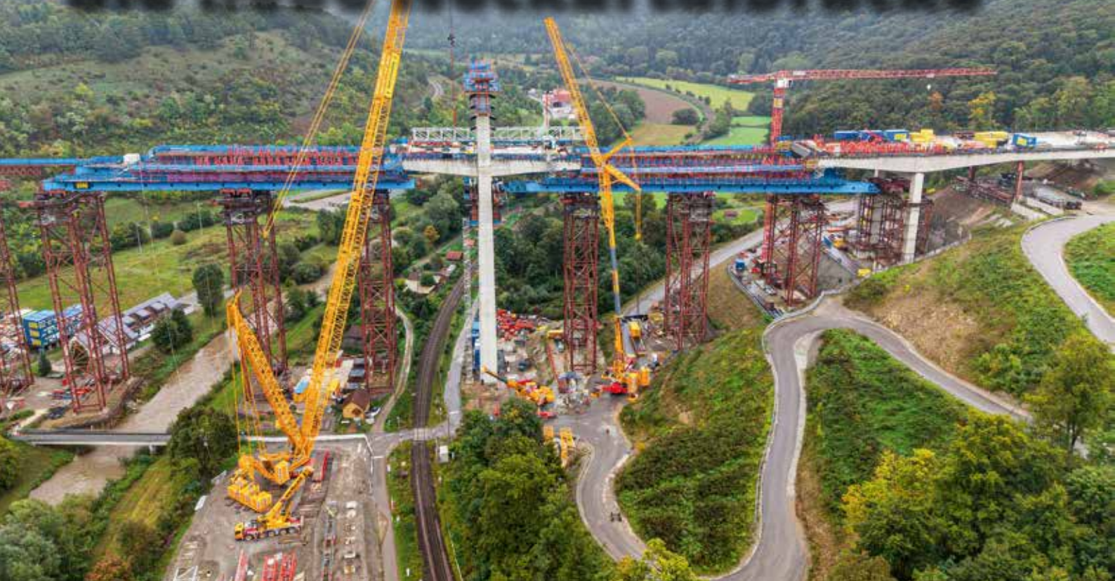
Wiesbauer hebt mit zwei Kranen Verstärkungsbleche auf die Fahrbahn der Hochbrücke Horb in 65 Metern Höhe.
