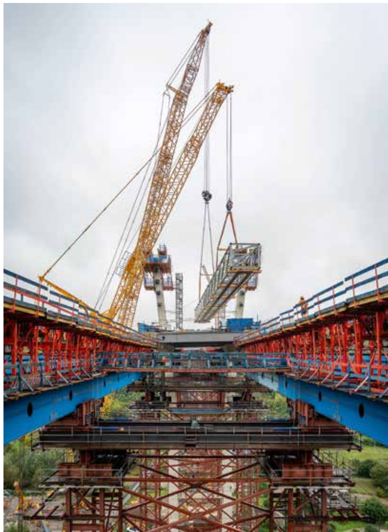
Um ein Durchbiegen der Bleche während des Hebens zu verhindern, wurden sie an einer Gittertraverse befestigt.
