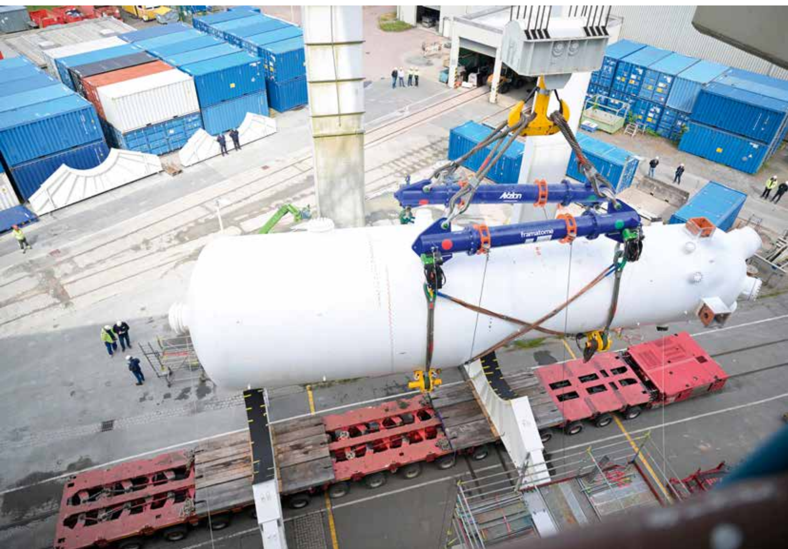
Der Dampferzeuger wird auf spezielle Halterungen abgesenkt um zur Entsorgung transportiert zu werden.
