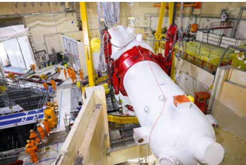
Ein verstellbarer Greifring wurde speziell dafür entwickelt, den zylindrischen Dampferzeuger sicher zu greifen.
