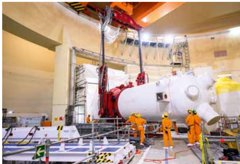
Das DHS-500, ein Spezialwerkzeug von Mammoet, dessen obere Traverse am Haken des Hallenkrans verbolzt wird.
