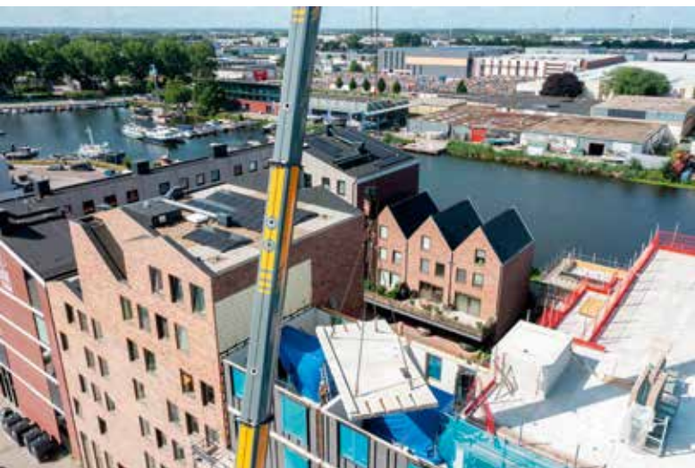
Der LTR 1150 platziert Elemente von 15 Tonnen passgenau in großer Höhe.
