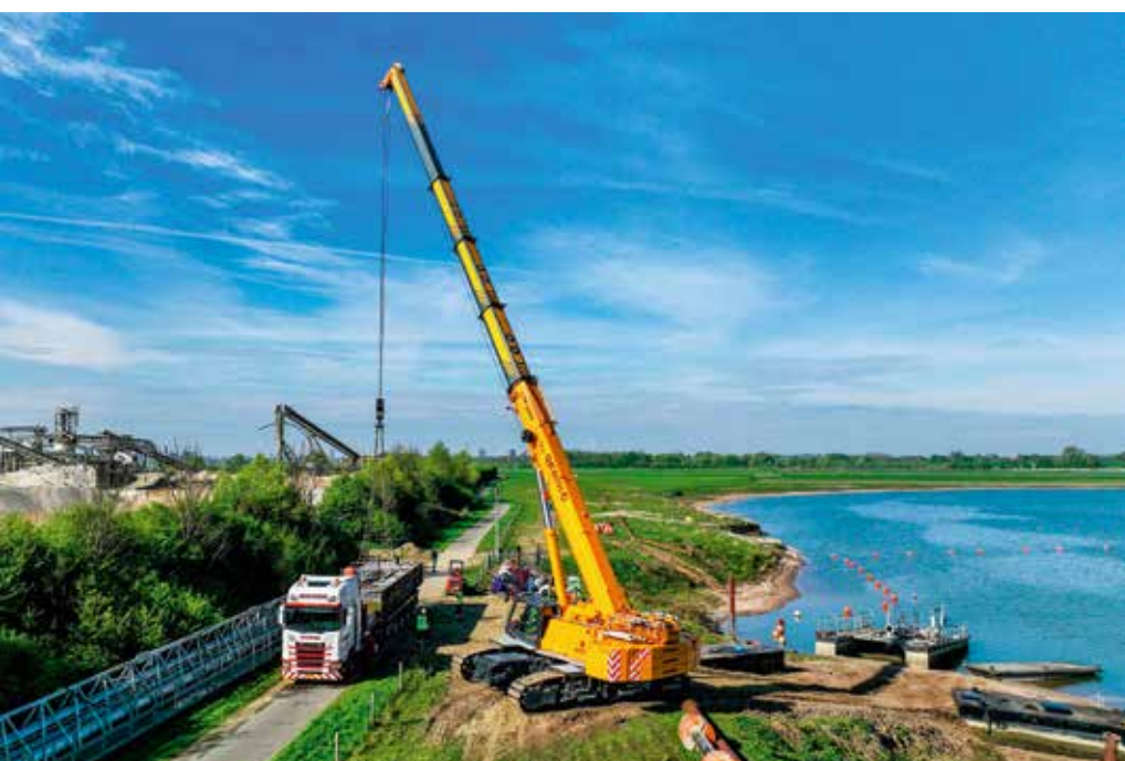
Auch bei der Montage von Sandbaggern auf Binnengewässern zeigt Gebris neuer LTR 1150 seine Stärken.
