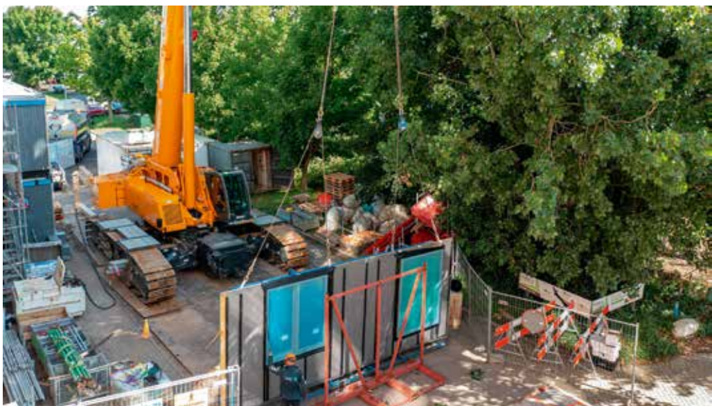
Container, Bäume und Baumaterial begrenzen die Stellfläche des Teleskop-Raupenkran.
