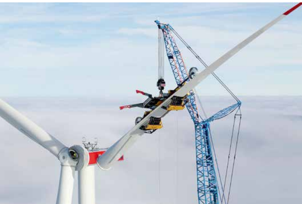
Das dritte Rotorblatt wird per Raupenkran und ematec-Traverse zur Montage geführt.
