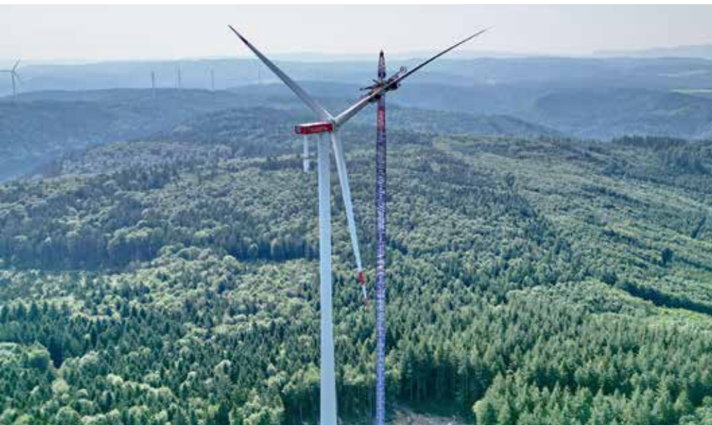
Trotz allem sind große Raupenkrane mit langen Gittermastauslegern für die Montage unabdingbar.
