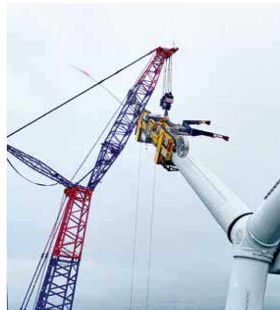
In der Kombination mit dem APS ermöglicht die RBC-D von ematec eine sichere Montage unabhängig von Witterungseinflüssen.
