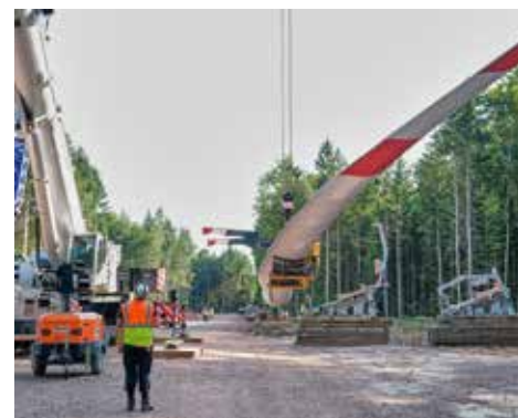
Ergriffen und abgehoben, das nächste Rotorblatt.
