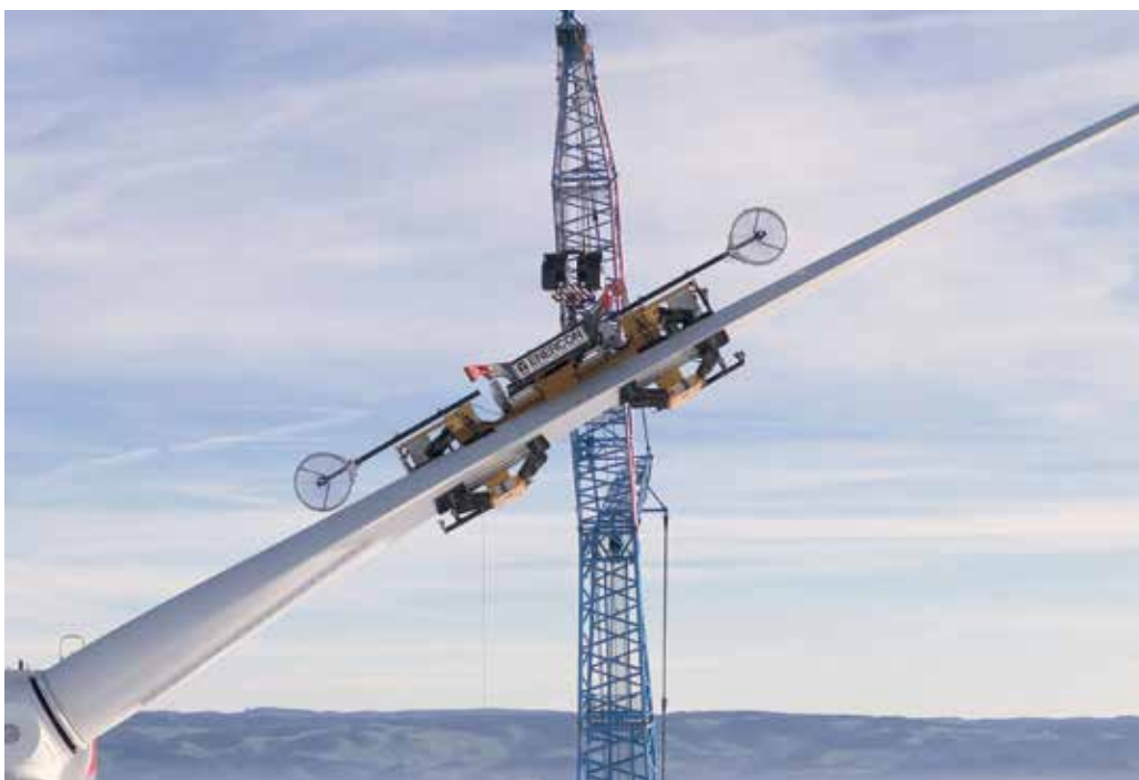
Das dritte Rotorblatt wird angeflanscht.
