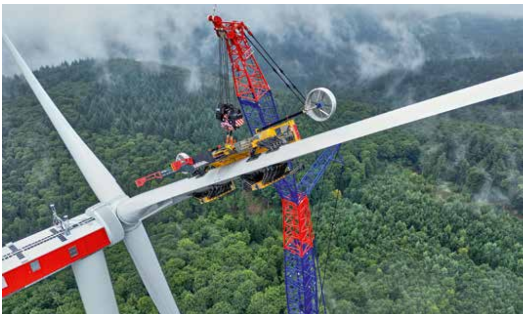
Die neue Traverse der RBC-D-Generation von ematec. Das „D“ steht für „Double“ und bedeutet, dass zusätzlich zum unteren auch der obere teleskopierbare Greifer mit vierzehn hydraulisch bewegten und kardanisch aufgehängten Griffpads ausgestattet ist.
