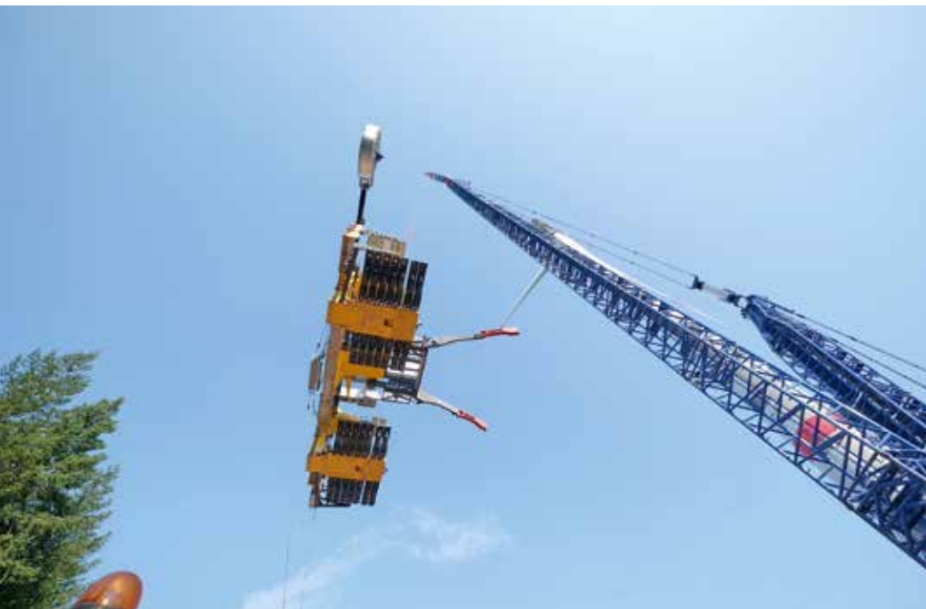
Die ematec-Traverse: bereit weitere Rotorblätter zu greifen.
