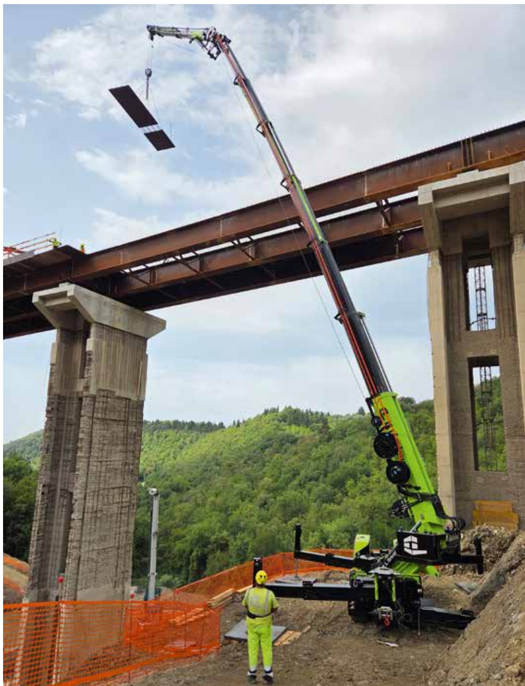
Der M4000 von BG Lift im Einsatz.
