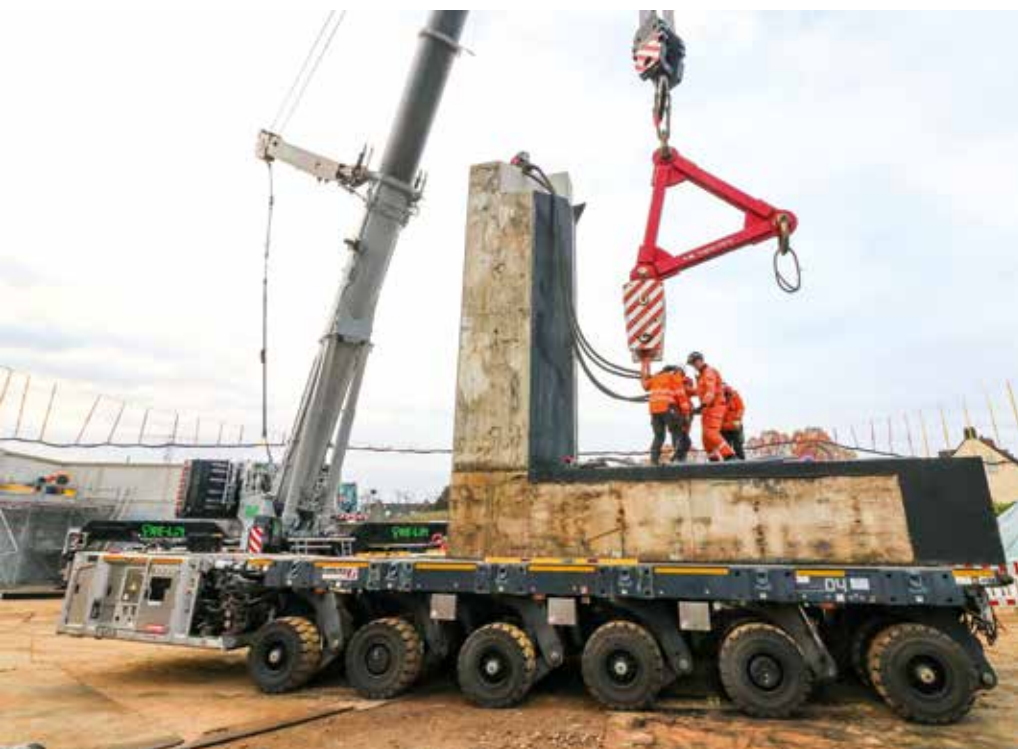
Die Winkelstützen werden von SPMTs für den Einhub angerollt und angeschlagen.
