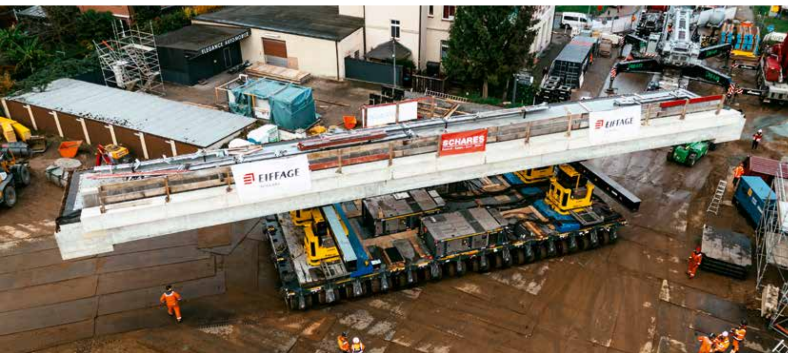
4 Hubanlagen auf 3x14 Achslinien manövrieren die Bahnbrücke.
