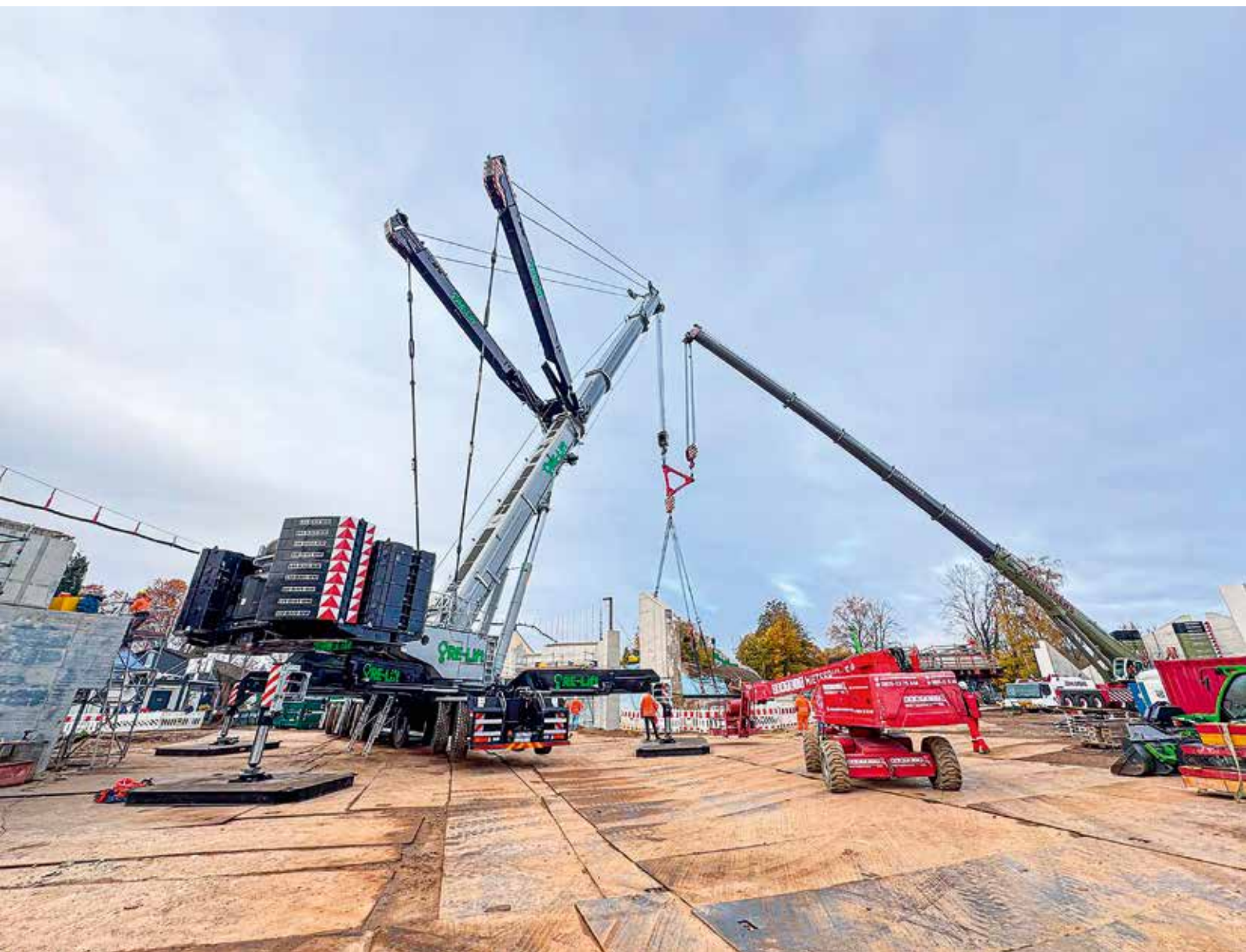
Tandemhub, gut erkennbar die Y-Abspannung am LTM 1750-9.1.
