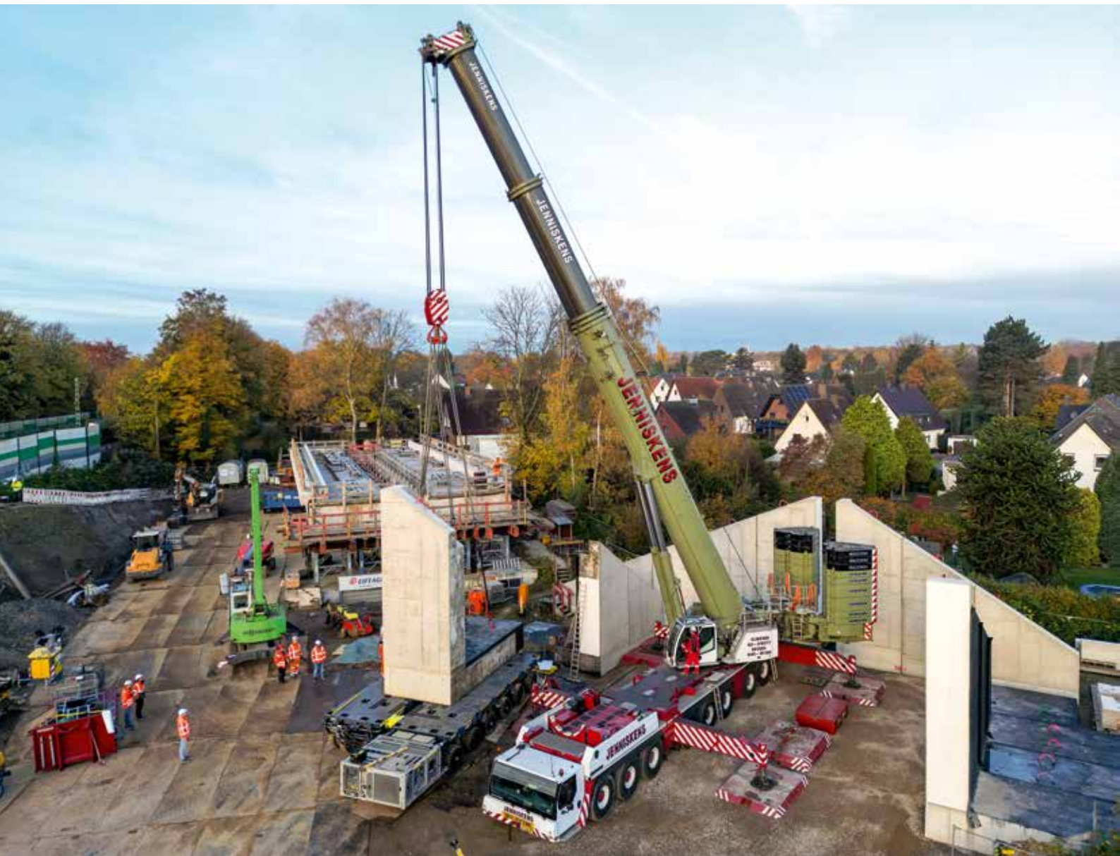
Eine Winkelstützwand am Haken des LTM 1450-8.1 von Jenniskens.
