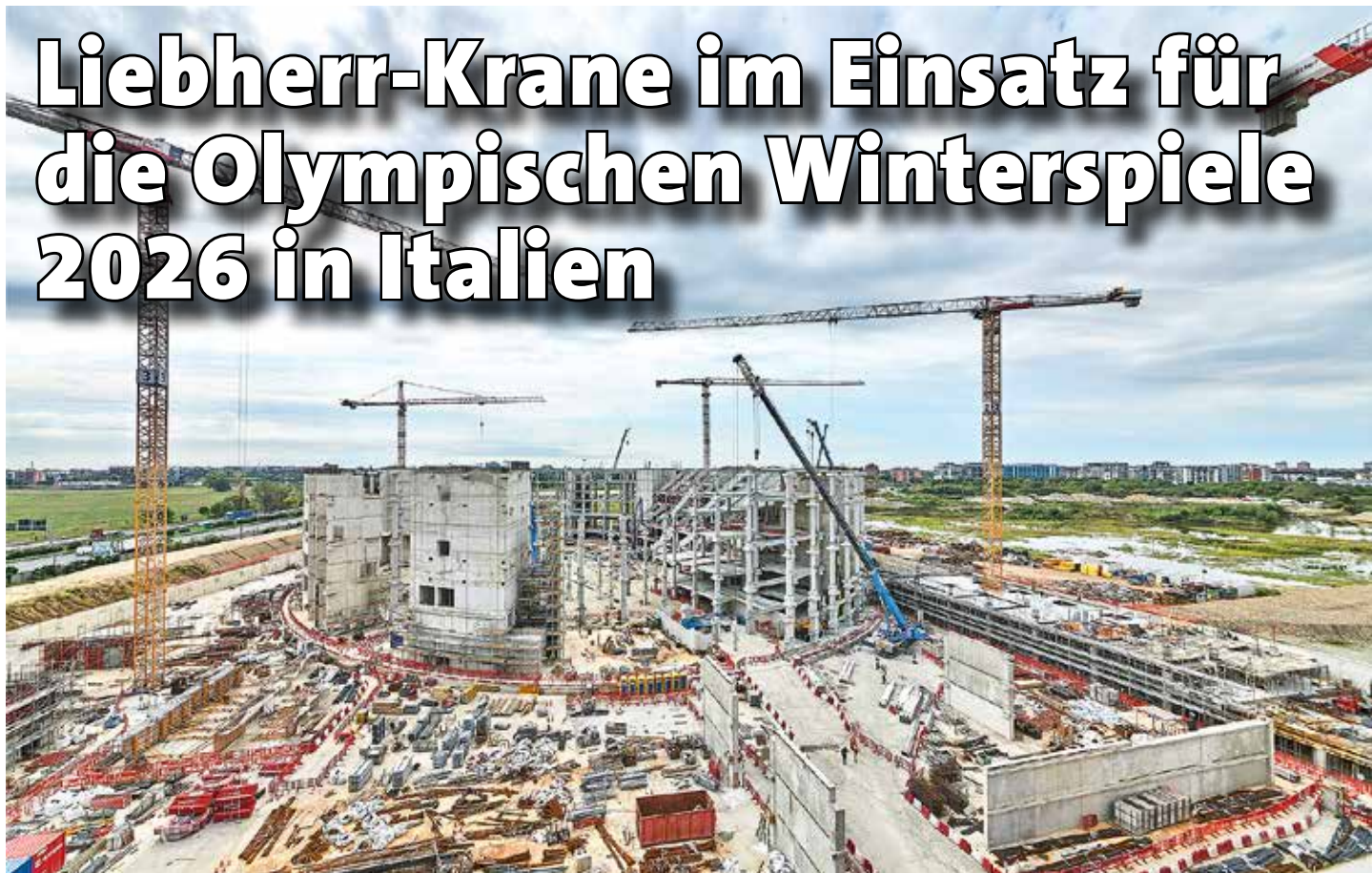
Liebherr-Obendreherkrane der Baureihen EC-B und EC-H beim Bau der Arena Milano.
