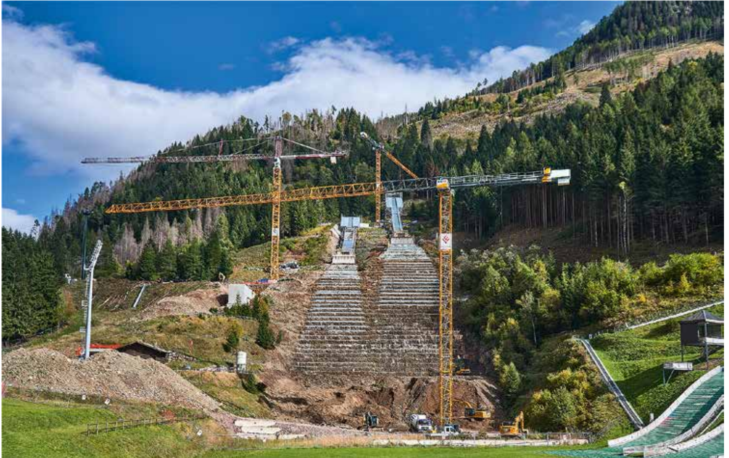
Liebherr-Turmdrehkrane der Baureihen EC-B und EC-H sind beim Bau der Skisprungschanzen in Predazzo im Einsatz.
