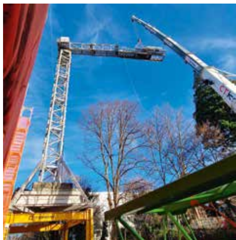
Stück für Stück wächst der 85 m lange Ausleger des Turmdrehkrans von Zoomlion.
