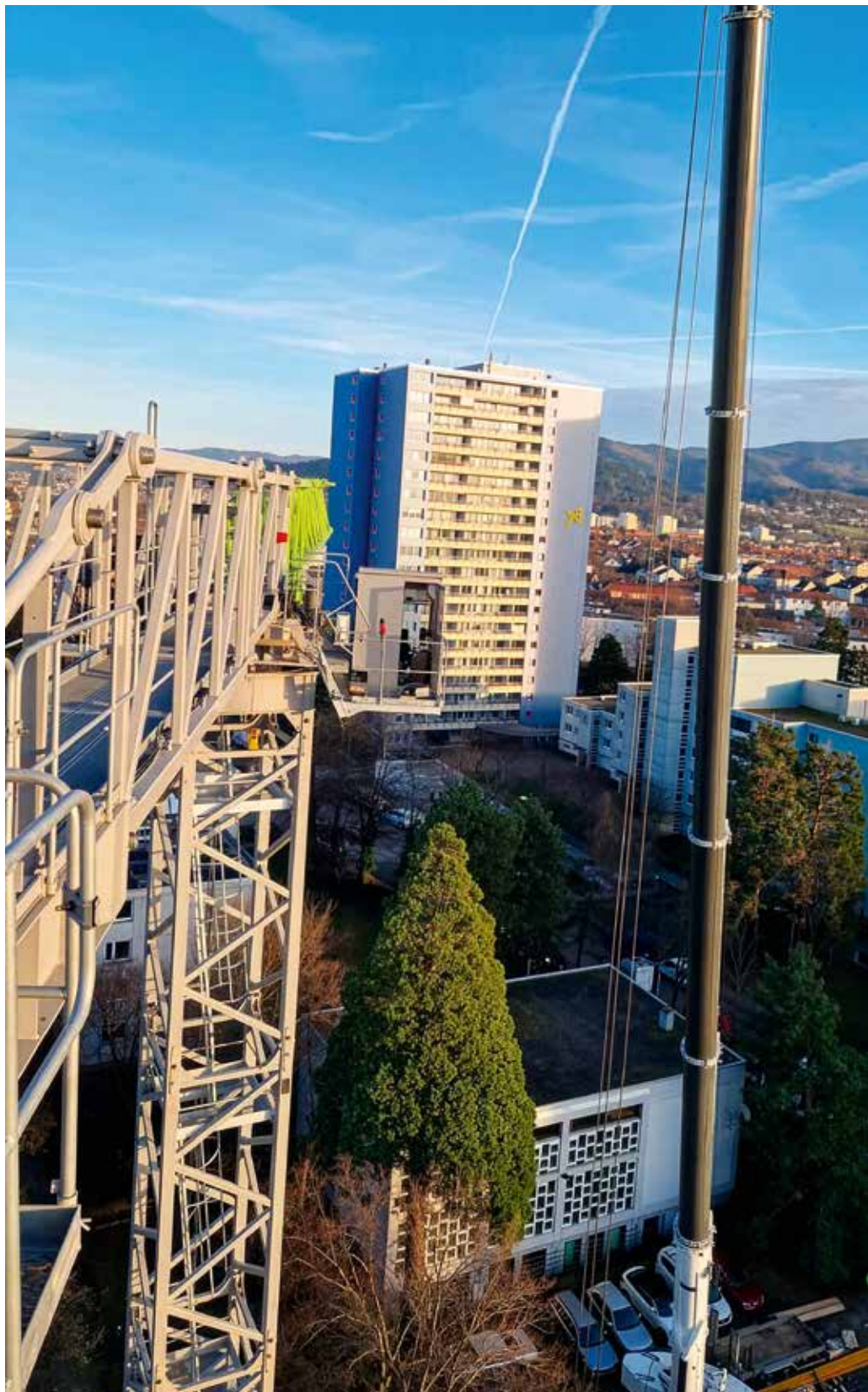
Die Auslegermonteure hatten einen guten Blick auf Freiburg im Breisgau.
