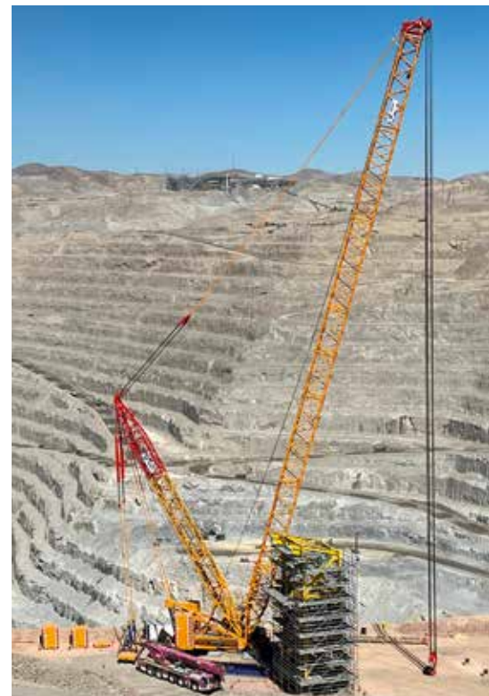
Der Aufbau des Tadano Gittermastraupenkrans CC 38.650-1 hat problemlos geklappt. Im Bild ist auch der Tadano AC 5.220-1 zu sehen, der als Aufbauhelfer benötigt wurde.
