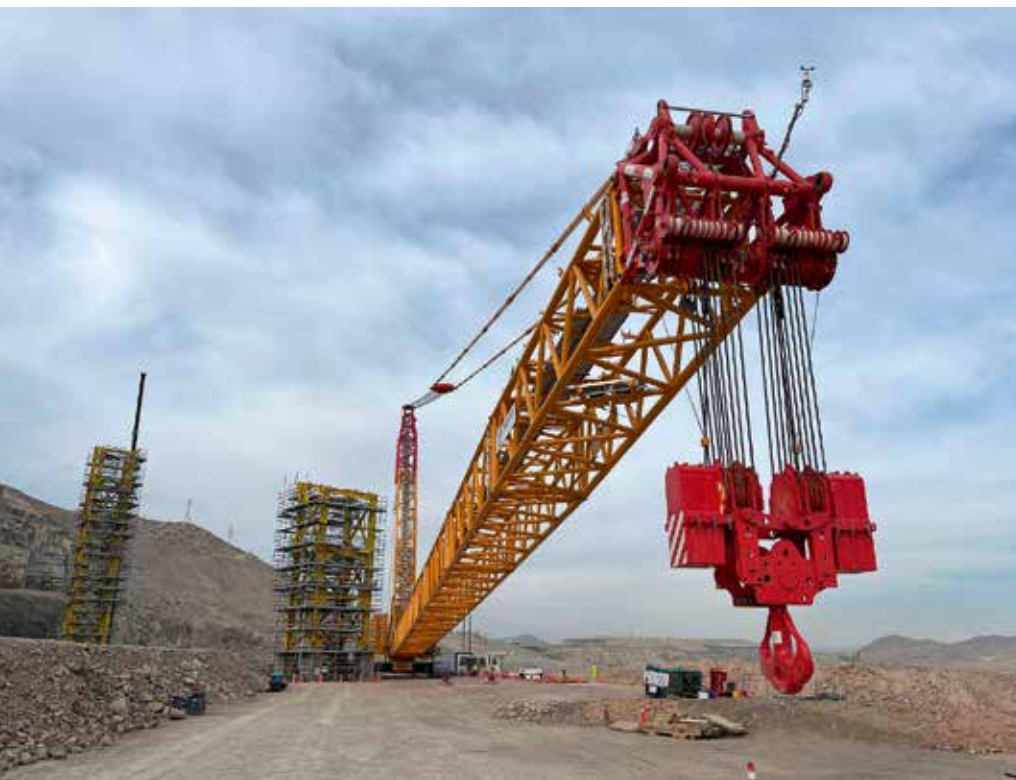
Da der Erstaufbau zugleich mit einer Schulung verbunden wurde, waren sechs Wochen für den Aufbau, der sonst nur wenige Tage in Anspruch nimmt, angesetzt.
