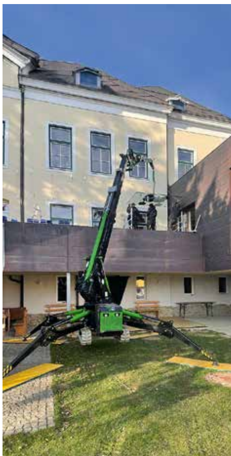
Auch beim Einsatz dieses M250 werden mit einem am Auslegerende angebrachten Manipulator Glasscheiben gehoben.
