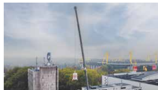
Gut erkennbar der Gelenkausleger dank dem die Materialien auch über Hindernisse hinweg.
