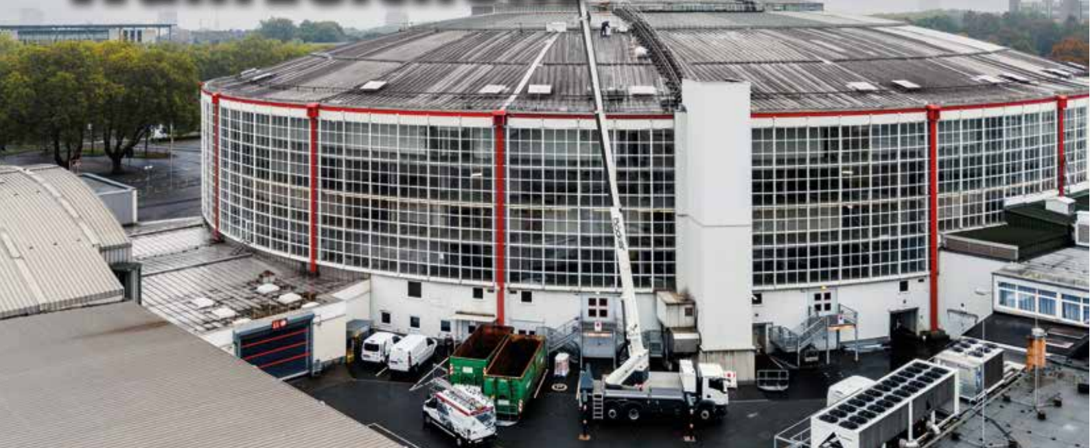
Der Böcker Autokran AK 48 im Einsatz an der Westfalenhalle Dortmund.
