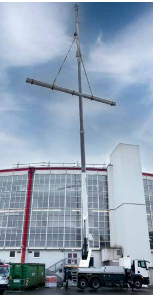
Mit dem AK 48 werden die neuen Kalzip-Aluminiumprofile in die Höhe gebracht, damit sie dort verbaut werden können.
