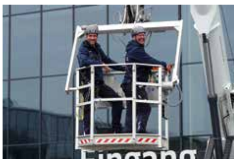
Die Sindermann-Mitarbeiter fühlten sich im Personenkorb sichtlich gut und sicher aufgehoben.
