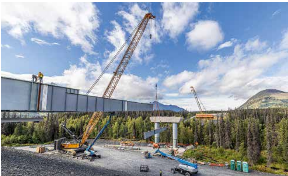
Zwei LR 1300.1 SX von Liebherr schließen die Lücke über den Juneau Creek Canyon.
