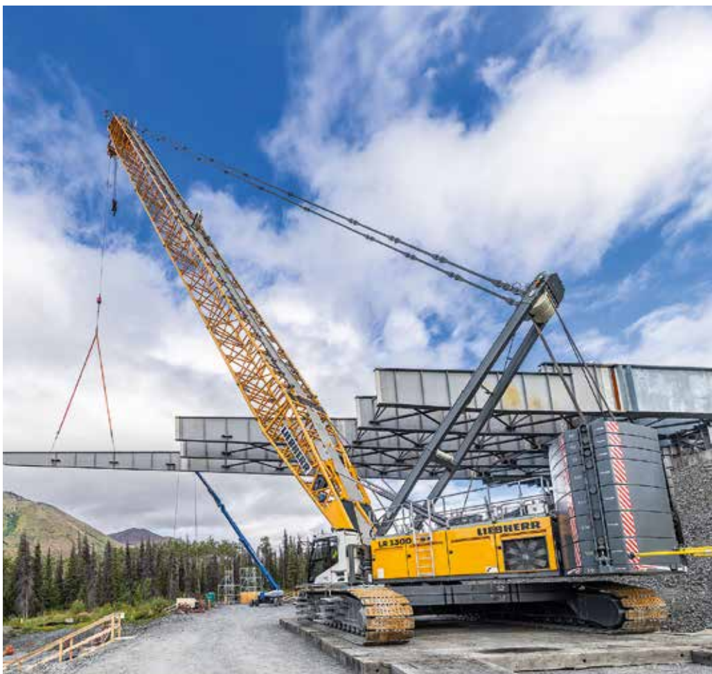
Die Stahlträger werden auf beiden Seiten der Schlucht von einem LR 1300.1 SX positioniert.
