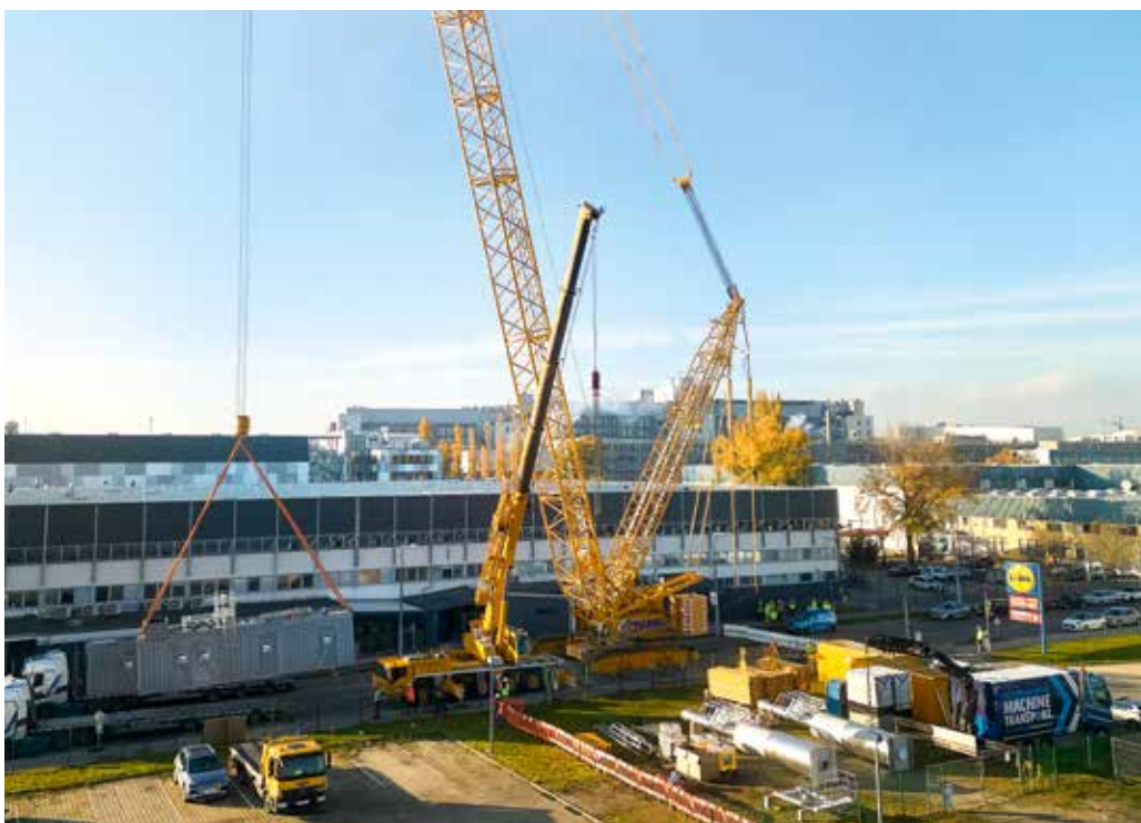
Der Hub des angeschlagenen Genset-Containers hat begonnen.
