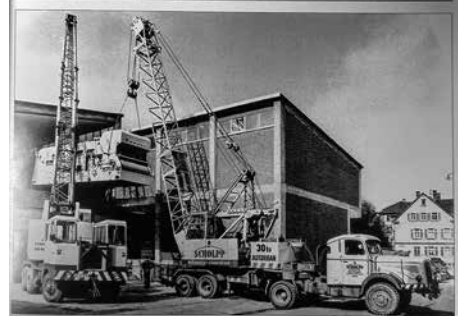
Stützgerüstliches Einbringen einer Maschine in eine Fabrikhalle. Wie damals oft praktiziert, mussten die Krane unter Last verfahren werden und waren dabei nicht abgestützt.
