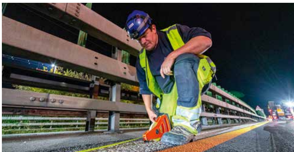
Auf der gesperrten Autobahn ermittelt Jörg Hodel, Projektleiter und Inhaber der Hodel SHLK AG, präzise die Kranstellflächen für den bevorstehenden Einsatz.
