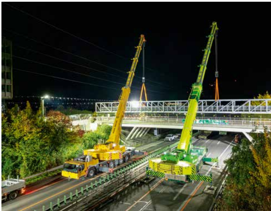
... danach lief die Montage der Rohrbrücke wie geprobt ab. Jeweils am Bildrand zu sehen sind die beiden Stromtrassen, die den Kranteams besondere Vorsicht abverlangten.
