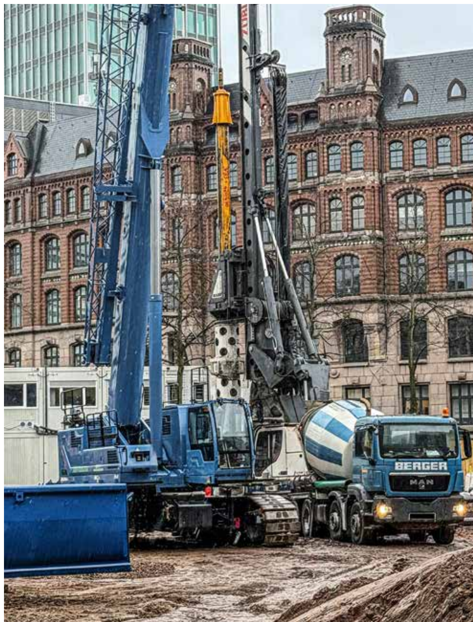
Der elektrische Teleskop-Raupenkran kann auch unter Last teleskopiert und verfahren werden.
