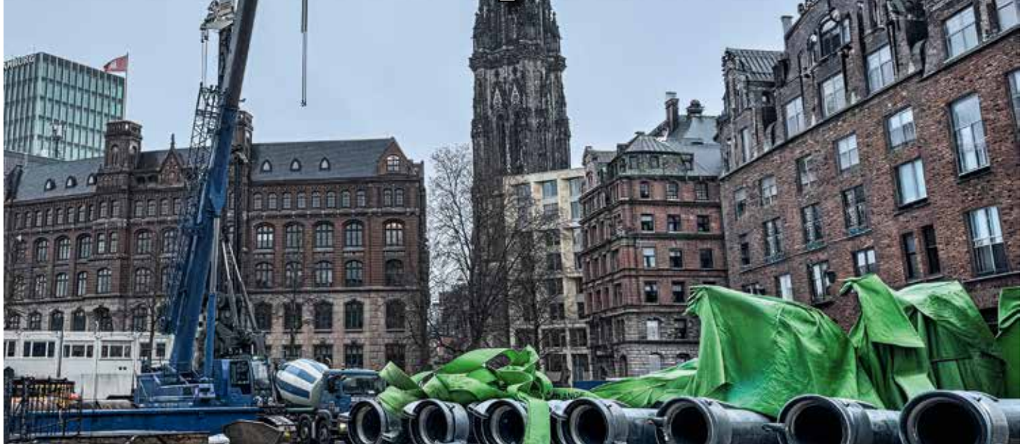
Auf der Baustelle in Hamburg übernimmt der Raupenkran unterschiedlichste Aufgaben.
