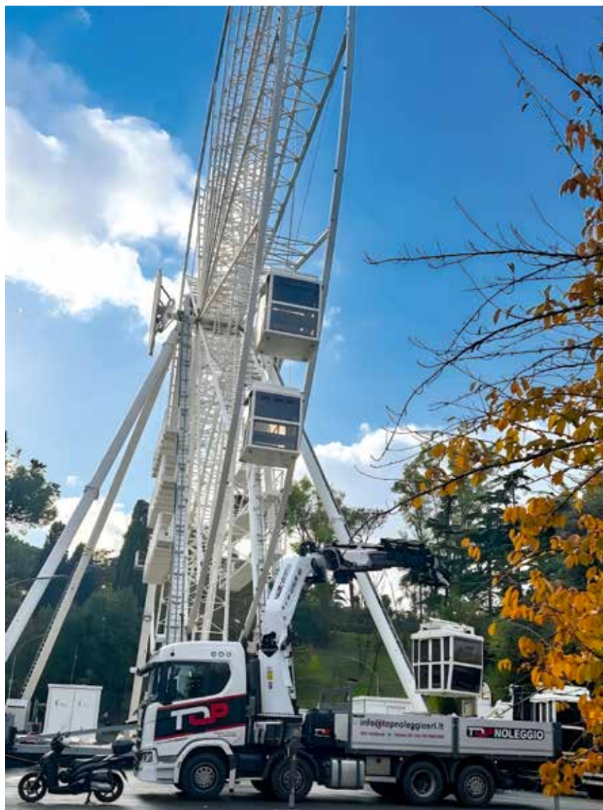
Die Riesenrad-Gondel ist am Haken des Ladekrans befestigt.
