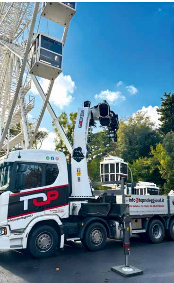
Insgesamt zwei Tadano Ladekrane – ein PM 100SP und ein PM 150SP – kamen zum Einsatz.
