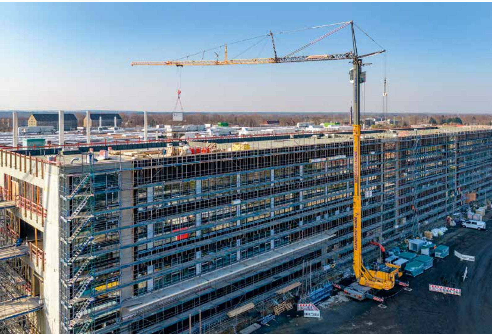
Tonnenschwere Komponenten einer Klimaanlage werden bei großer Ausladung vom MK 140-5.1E positioniert. Die gebäudenähe Stellfläche des Mobilbaukrans stellt keine Beeinträchtigung der vorbeiführenden Baustraße dar.
