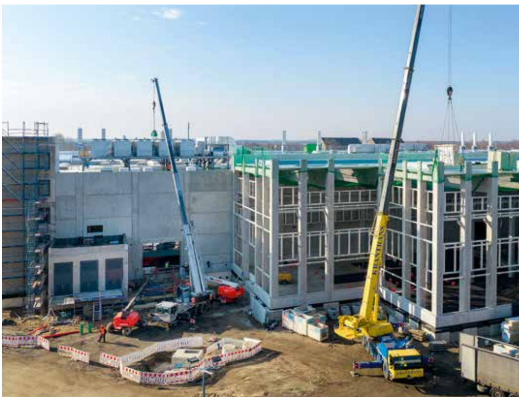
Zum Transport von Dämmmaterial im Einsatz: ein LTM 1030-2.1 sowie ein LTM 1090-4.1 auf der Baustelle in Cottbus.
