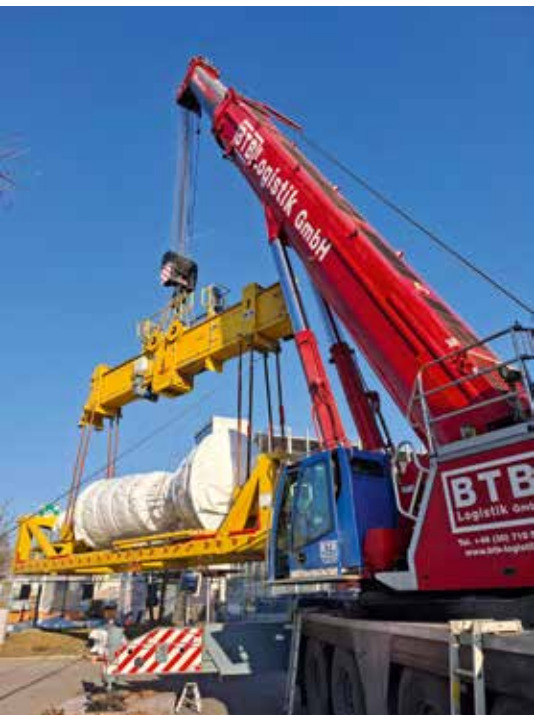
Am Haken des Liebherr LTM 1450-8.1 befanden sich mit Traverse rund 220 Tonnen, die für den Weitertransport dann in Position gebracht wurden.
