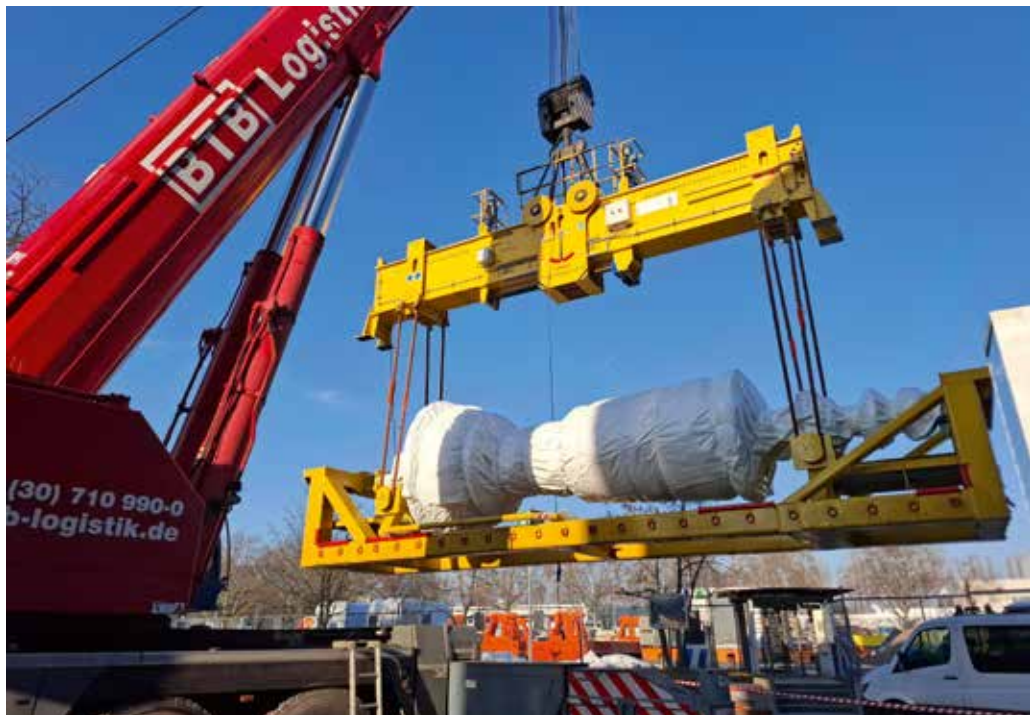
Am Haken des Liebherr LTM 1450-8.1 befanden sich mit Traverse rund 220 Tonnen, die für den Weitertransport dann in Position gebracht wurden.
