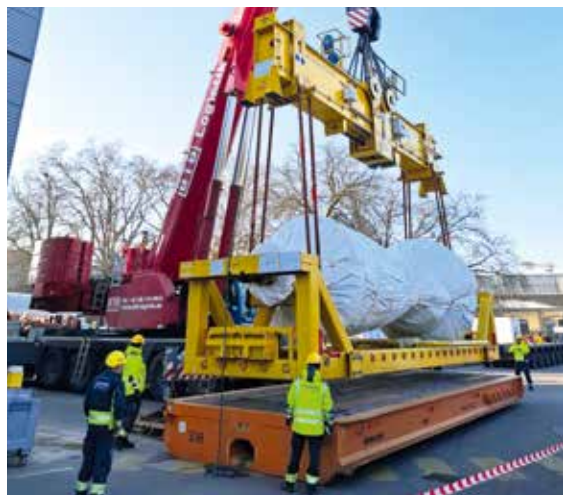
Am Haken des Liebherr LTM 1450-8.1 befanden sich mit Traverse rund 220 Tonnen, die für den Weitertransport dann in Position gebracht wurden.
