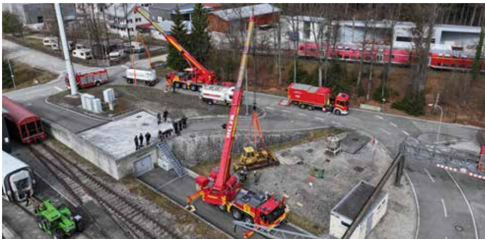
Die Bergung von schweren Fahrzeugen gehört zum breiten Einsatzbereich von Feuerwehrranen.
