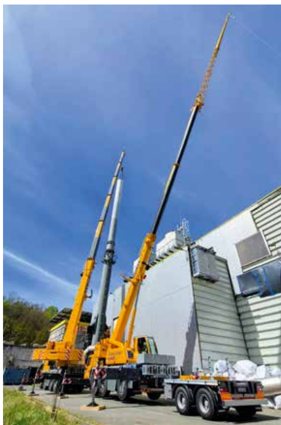
Gemeinsam im Einsatz: Zusammen mit einem LTM 1120-4.1 demonstrierte der LTM 1055-3.3 einen Schornstein in Dresdens ehemaliger Müllverbrennungsanlage.
