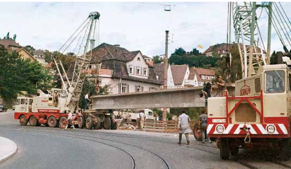
Ein Betonfertigteil wird im Jahr 1963 per Tandemhub eingehoben.
