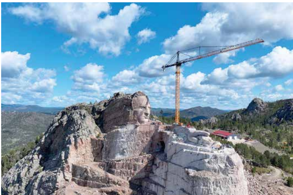
Ein weiterer Liebherr High-Top-Kran vom Typ 1000 EC-H von Morrow wird den bereits vorhandenen Liebherr-Turmdrehkran auf der legendären Baustelle des Crazy Horse ergänzen.
