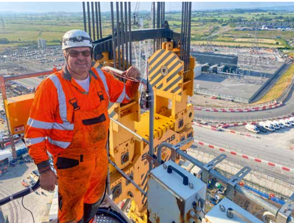
Eins ist klar: Als Techniker im Bereich Turmdrehkrane sollte man schwindelfrei sein.
