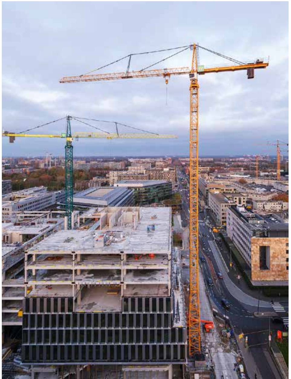
An einem innerstädtischen Standort mit begrenztem Lagerplatz und engen Zufahrtswegen ist die zentrale Positionierung der Krane ein entscheidender Vorteil.
