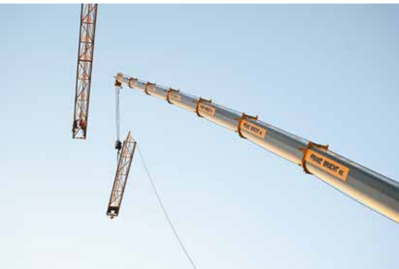
Der Liebherr-Mobilkran nahm jedes Segment millimetergenau auf. Bild: © SWB Mülheim | PR-Fotografie Köhring
