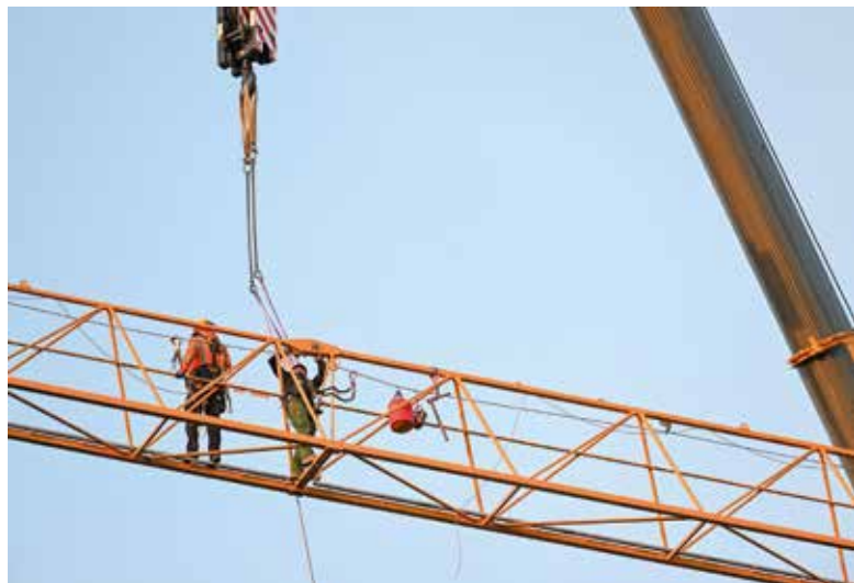
Unter freiem Himmel lösten die Monteure die Segmente des 75 Meter langen Auslegers Bild: © SWB Mülheim | PR-Fotografie Köhring
